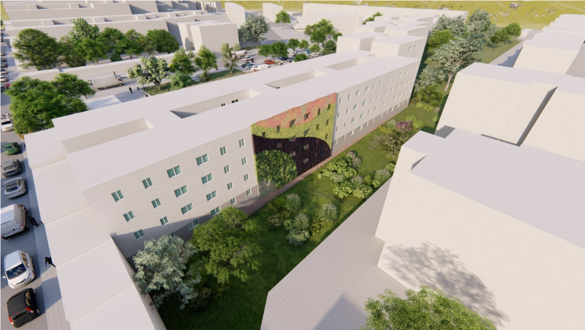
Figura 93. Vista aérea de la fachada este del edificio (elaboración propia)
