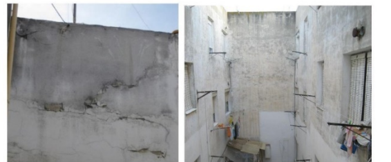
Figura 58. Lesiones observadas en la fachada norte (obtenida de Serrano Lanzarote 2016)
