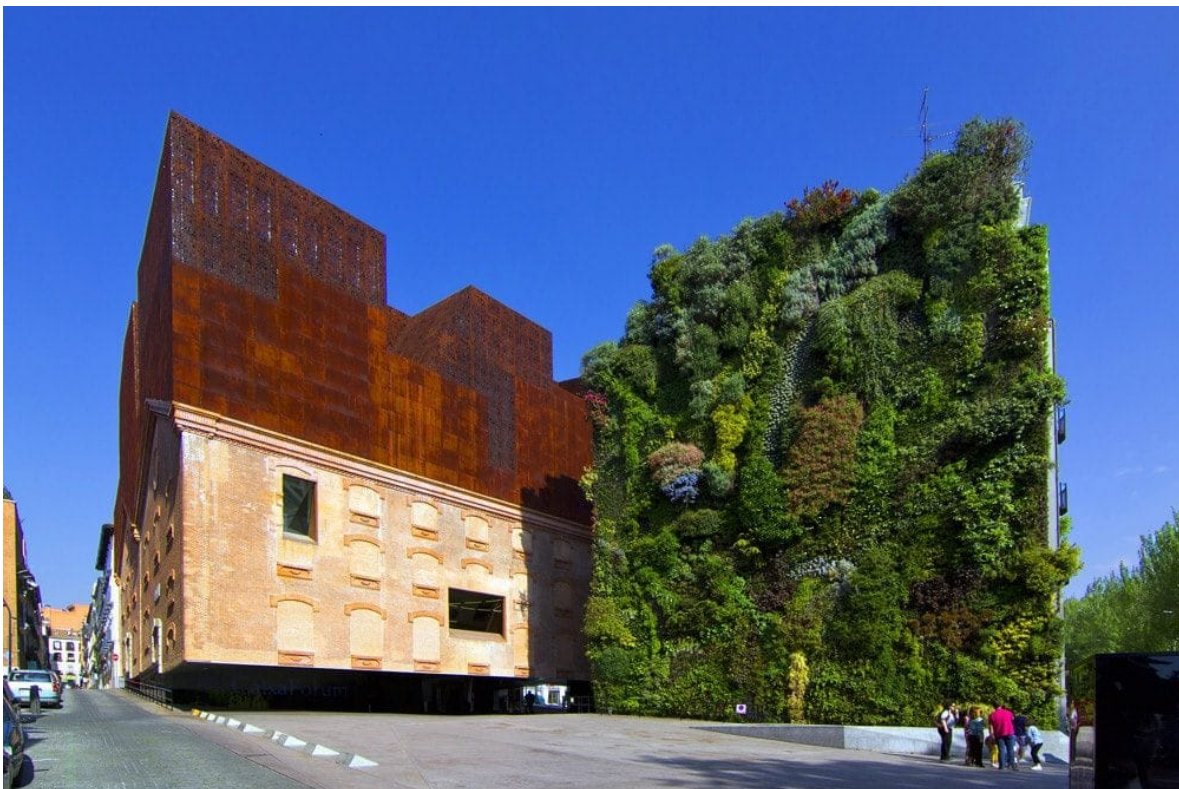
Figura 10. Fachada hidropónica del edificio Caixa forum de madrid. Patente de Patric Blanc. ( https://planometromadrid.com.es/caixaforum/ )
