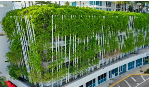
Figura 21. Proyecto Bentley Bay GreenSolutions (Jakob Rope Systems, s.f.)
