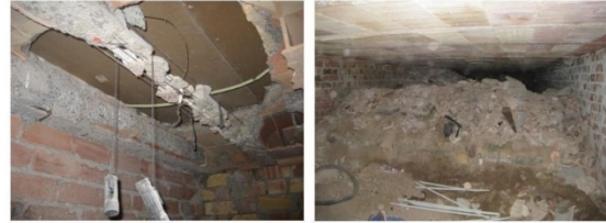
Figura 60. Lesiones observadas en el suelo (obtenida de Serrano Lanzarote 2016)
