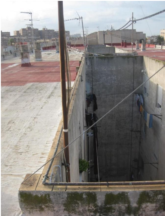
Figura 55. Vista de la cubierta del edificio (obtenida de Serrano Lanzarote 2016)
