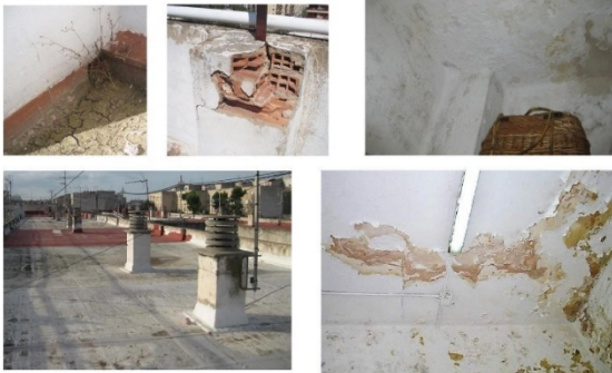
Figura 59. Lesiones observadas en la cubierta (obtenida de Serrano Lanzarote 2016)
