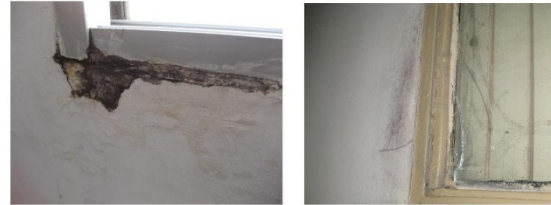
Figura 61. Lesiones observadas en las ventanas (obtenida de Serrano Lanzarote 2016)
