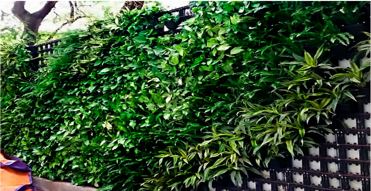
Figura 77. Muros curvos conformados por el sistema NaturPots ( https://paisajismourbano.com/es_ES/sistema-jardin-vertical-modular-naturpots )
