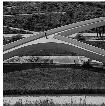
Figura 6. Grupo Aranea. Pasarelas Valle Trenzado en Elche. 2012-2014
