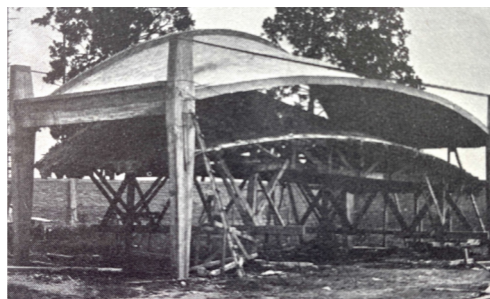
Figura 20. Proceso constructivo de la Fábrica Fernandez. 1950
