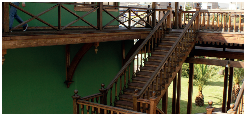
Autoría propia (2008) Pasillos exteriores de Estación FCAB [Fotografía].
