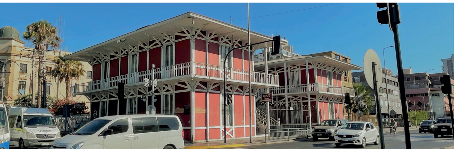
Figura 49. Edificio de la Antigua Aduana de Antofagasta. Fuente: Autoría propia (2021).
