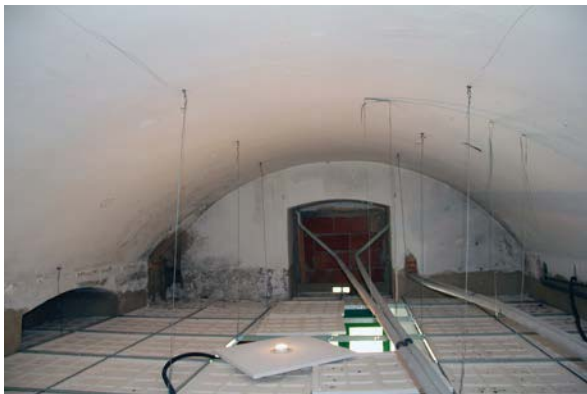
Figura 3: Estructura horizontal entre plantas. Bóveda.
