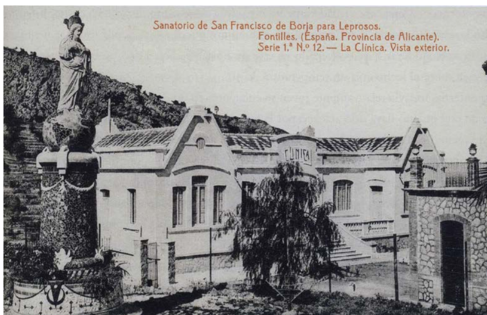
Figura 5: La Clínica. Vista exterior. 1924 (AHF, Fondos fotográficos, G.1.13).
