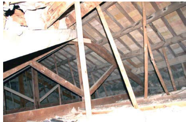
Figura 4: Intrados cubierta. Cerchas de madera.
