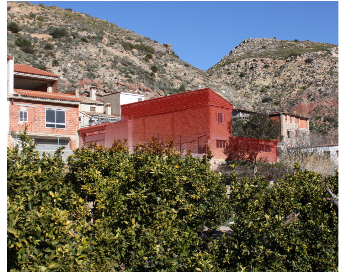
Fotografía 2, Demolición. Fuente propia
