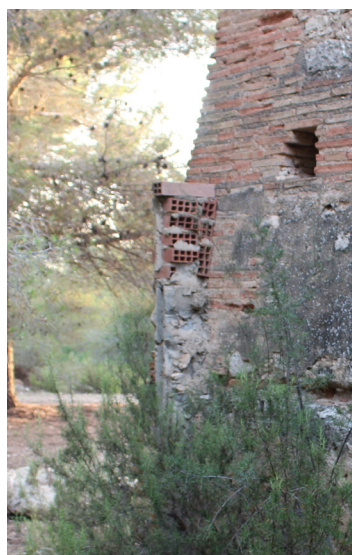
Fig. 23, Estructura anexa Fuente: Bas, 2021
