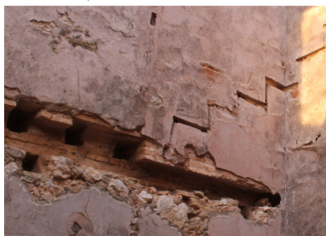
Fig. 25, Huellas de forjado y escalera Fuente: Bas, 2021
