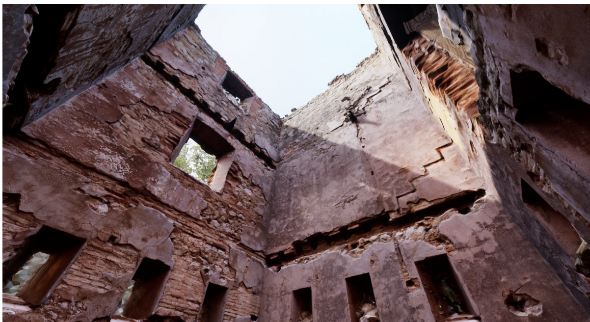
Fig. 123, Resultado final. Interior de la torre actual Fuente: Bas, 2021
