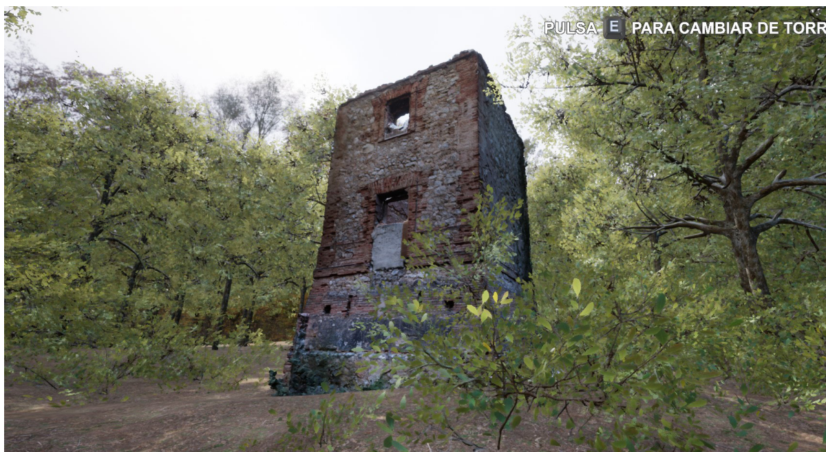
Fig. 119, Resultado final. Exterior de la torre actual Fuente: Bas, 2021
