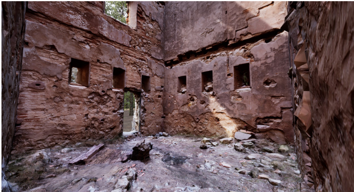
Fig. 122, Resultado final. Interior de la torre actual Fuente: Bas, 2021
