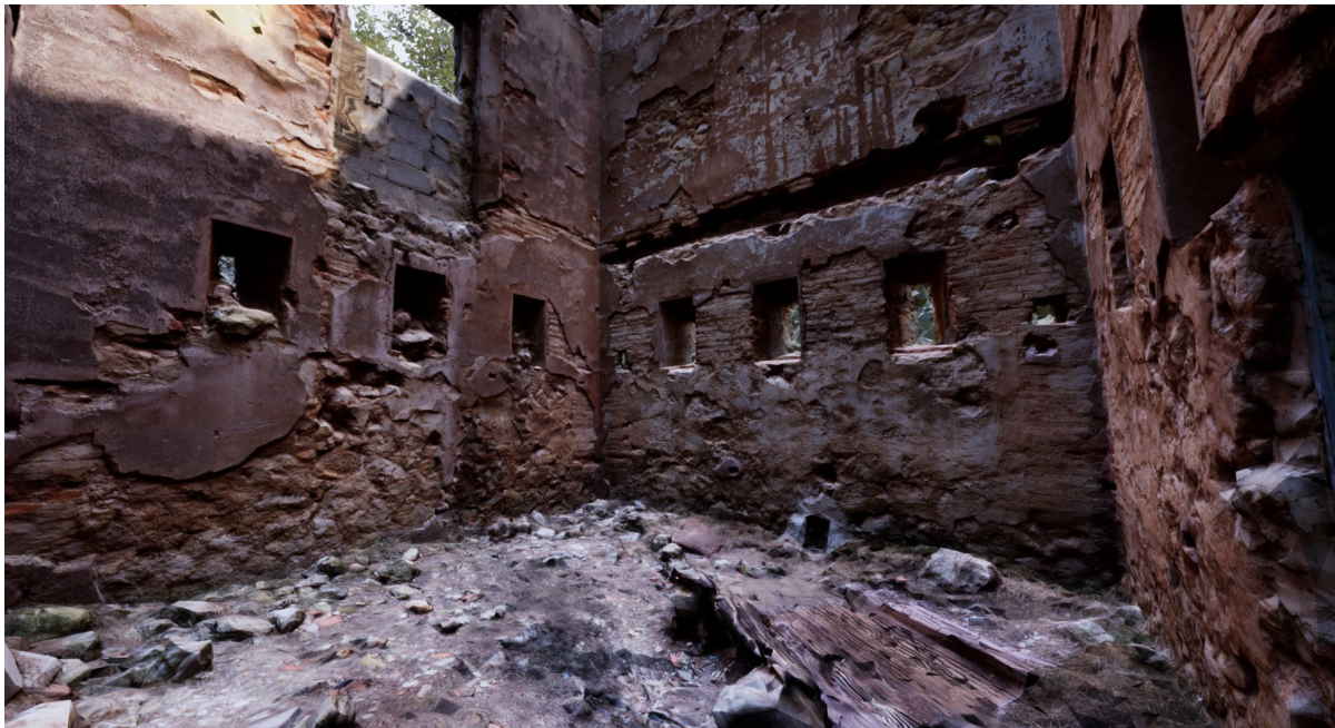
Fig. 120, Resultado final. Interior de la torre actual Fuente: Bas, 2021
