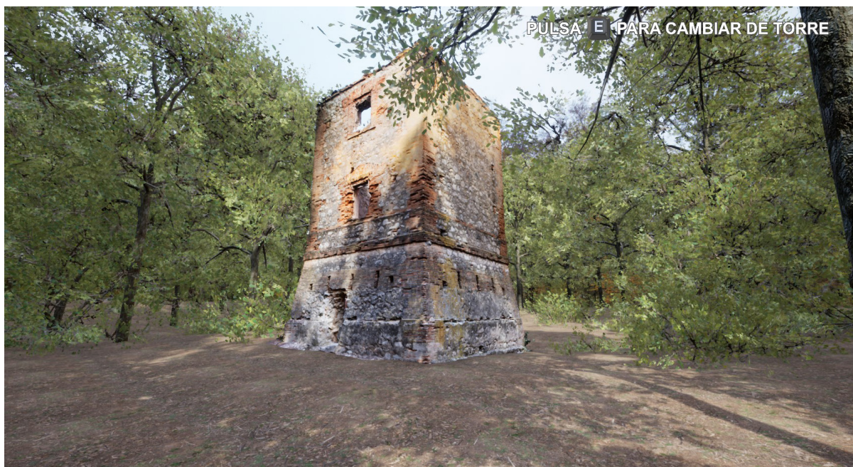
Fig. 118, Resultado final. Exterior de la torre actual Fuente: Bas, 2021
