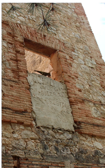
Fig. 24, Acceso original tapiado Fuente: Bas, 2021
