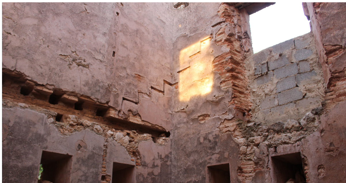
Fig. 51, Marcas de los peldaños de la escalera y las vigas de los forjados. Fuente: Bas, 2021
