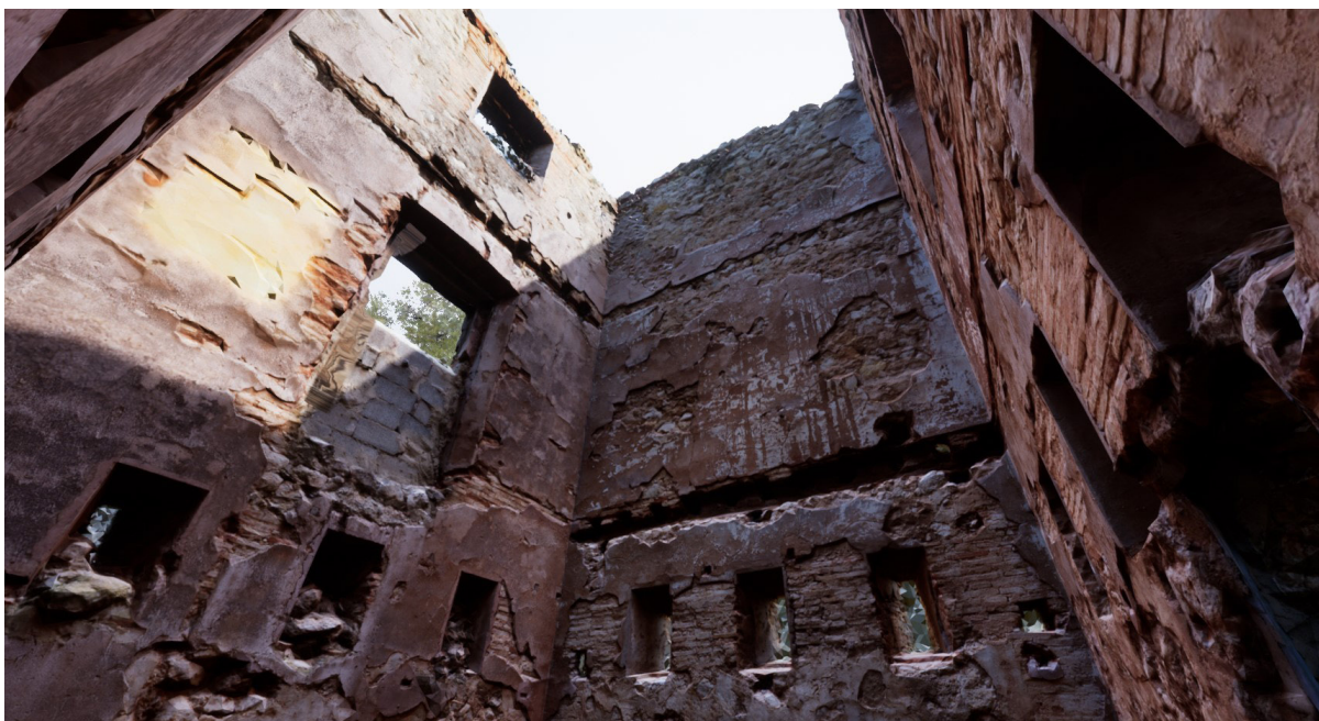
Fig. 121, Resultado final. Interior de la torre actual Fuente: Bas, 2021
