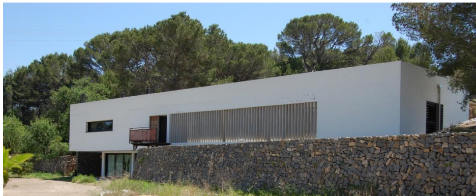
Figura 4.11: Fotografía de vivienda unifamiliar de Altea
