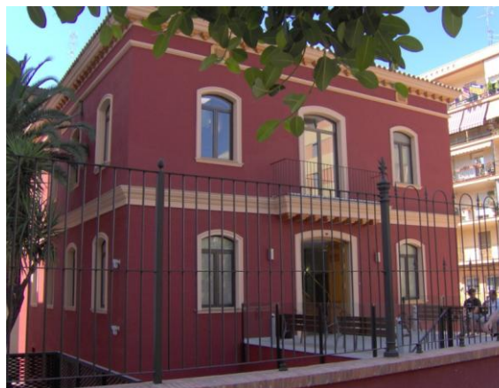
Figura 4.10: Fotografía del Centro sanitario de Paterna-Campamento
