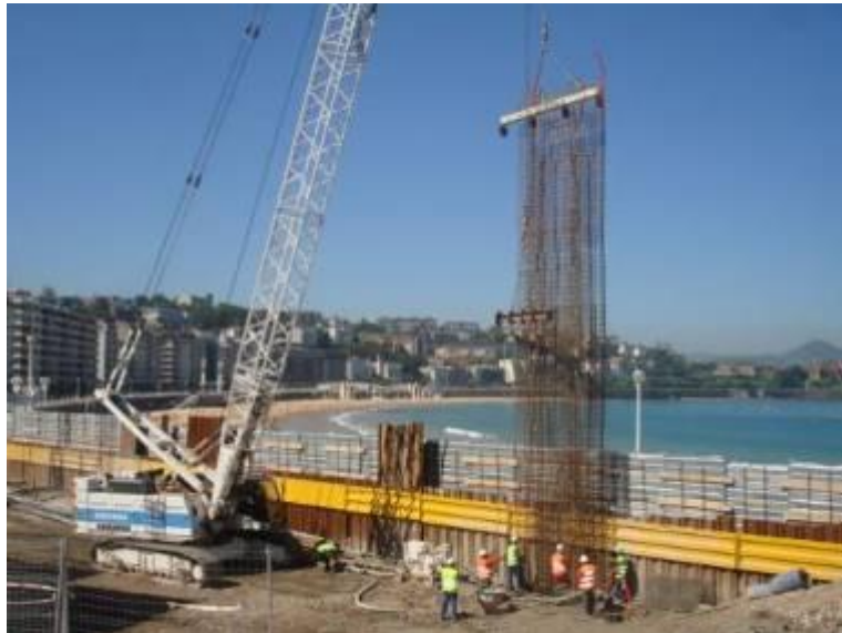
Figura 4.6: Fotografía de la obra del Centro
