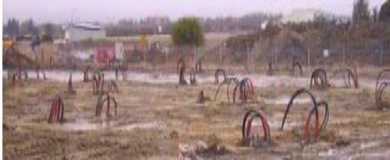
Figura 4.5: Fotografía de la obra
