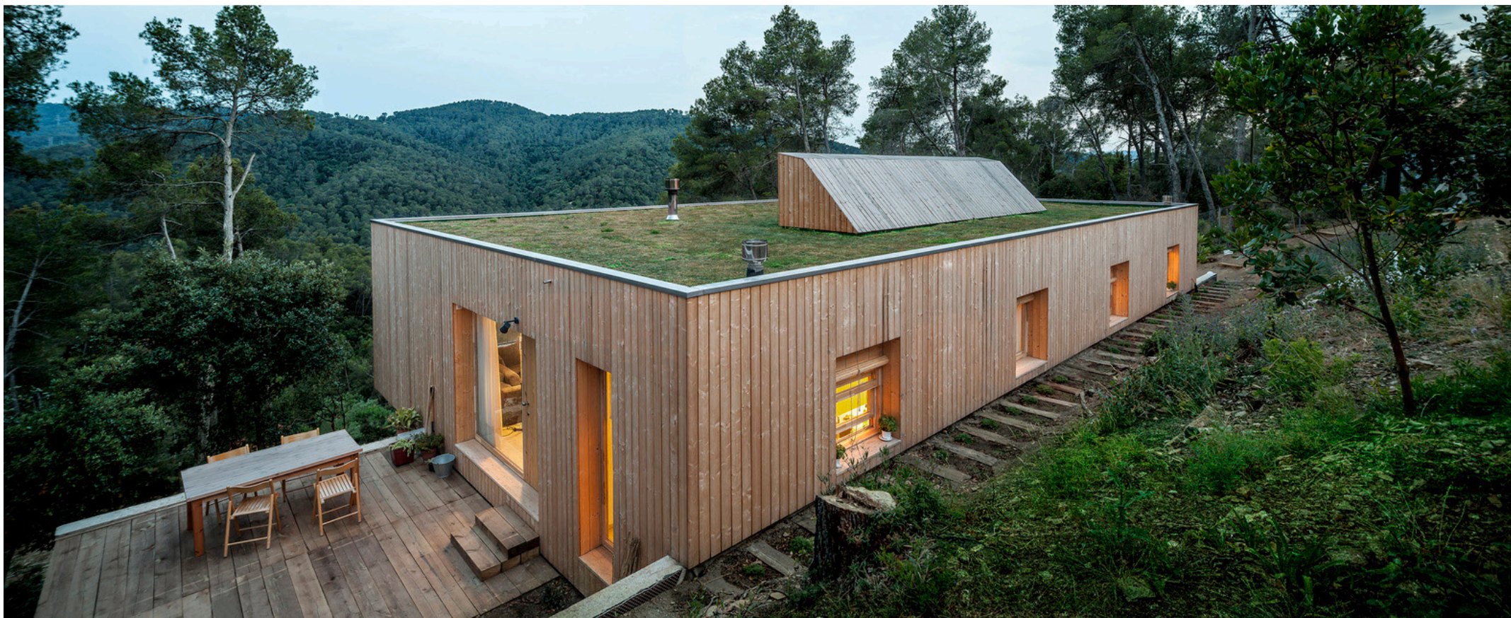
Fig. 5.4 Casa LLP de Alventosa Morell Arquitectes, fachada sur.
