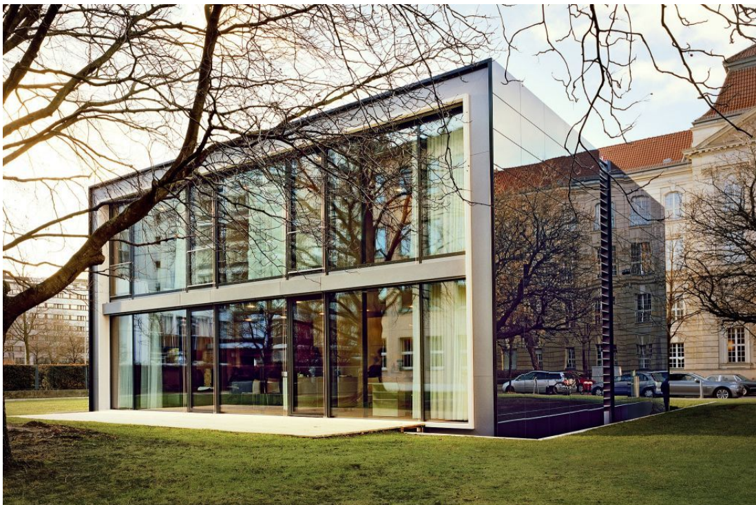
90 Vistas trasea y frontal F78. DBZ Vivir del futuro F87 - Efficiency House Plus con electromovilidad. [DBZ]
