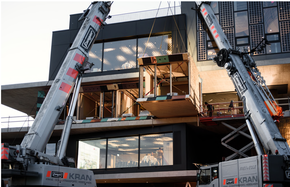
113 Instalación de un módulo de la UMAR desde fachada. [NEST-UMAR.net]
