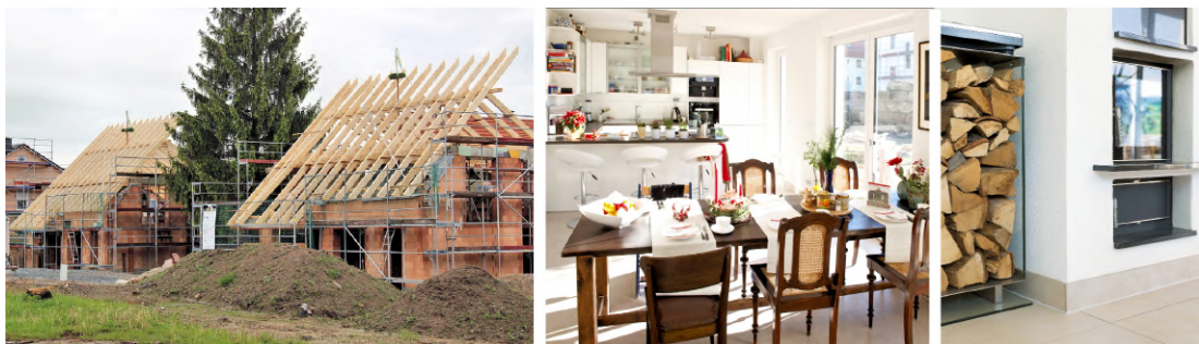
23 Muros de ladrillo macizo de inercia térmica y estructura de madera en el tejado.
