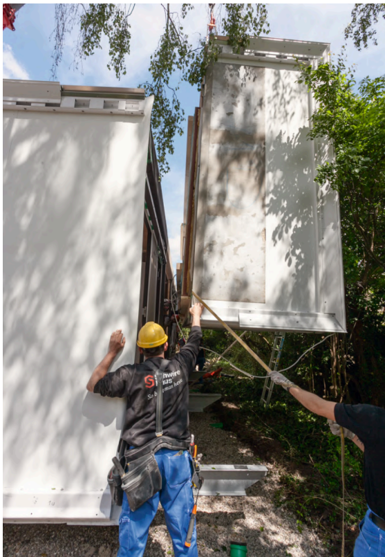
101 Ensamblaje en seco de las dos piezas prefabricadas. [DBZ]
