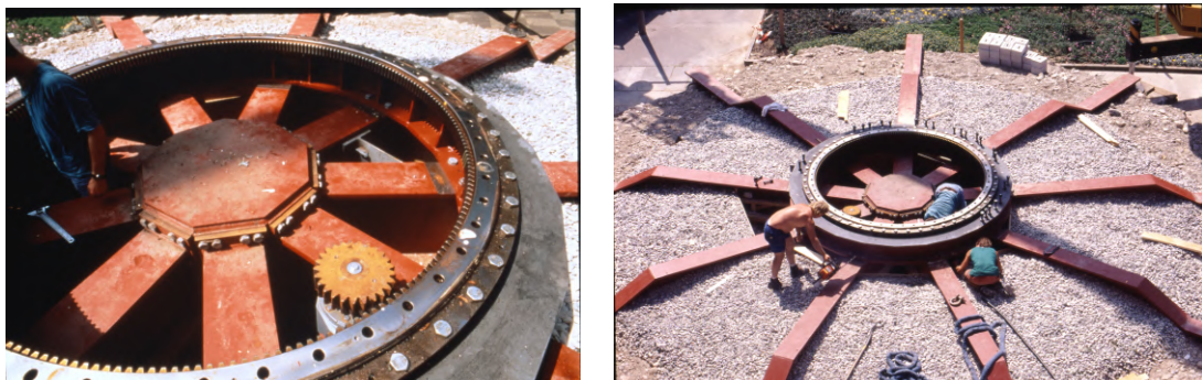
18 Detalle durante la construcción de la cimentación del núcleo giratorio. [bubblemania.fr]
