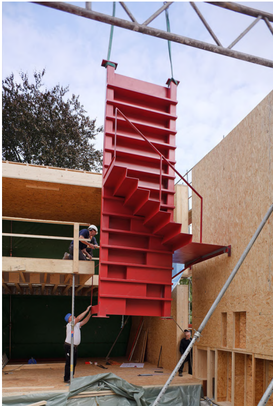
96 Montaje de la escalera prefabricada. Construcción del núcleo tecnológico en el escaparate del edificio. [DBZ]
