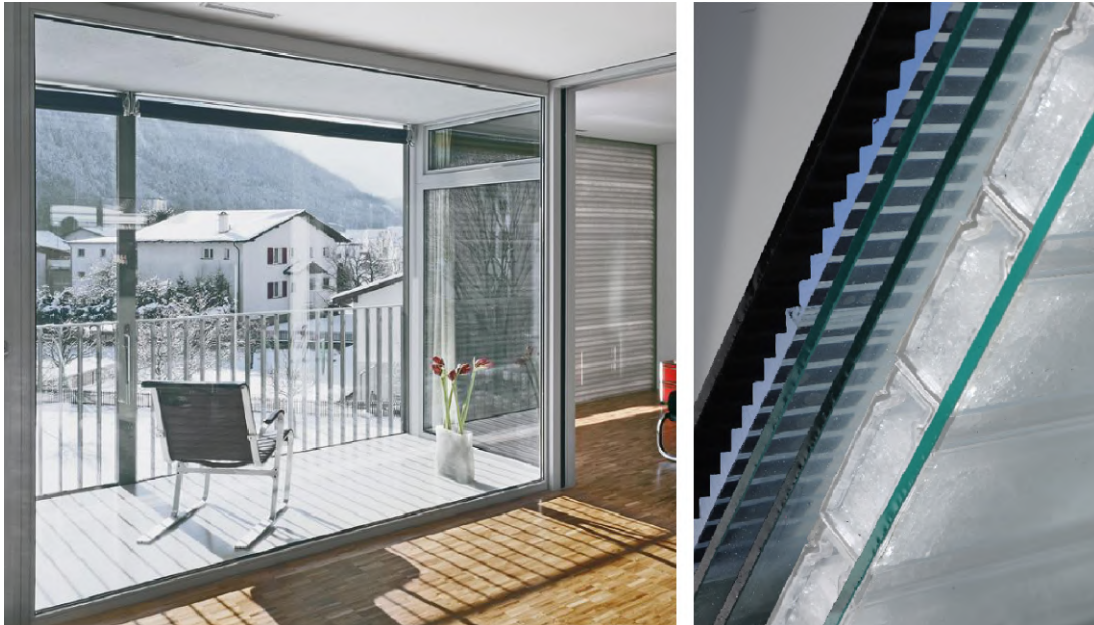
59 Fachada Sur acristalada. Fachada Norte más compacta. Interior apartamento. Detalle de GlassX.
