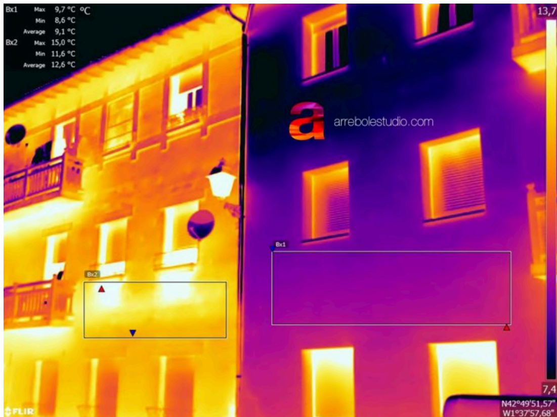
53 Termografía cuantitativa de fachadas. [Arrebolestudio. Análisis termográfico en la rehabilitación energética]
