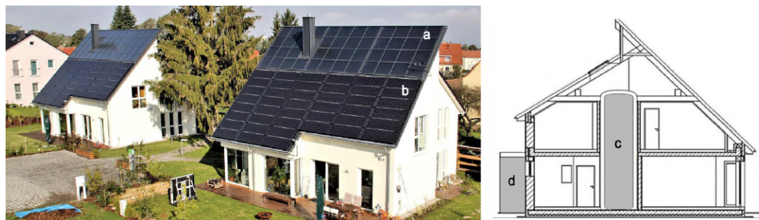
21 a) Colectores integrado en cubierta solar térmica. b) Placas Fotovoltaicas. c) Acumulador térmico de almacenaje prolongado. d) Batería de almacenaje exterior.
