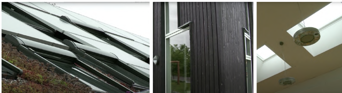
32 Paneles solares y lucernarios. Fachada de madera aislante. Lucernarios e Iluminación LED. [Solhuset I Horsholm]
