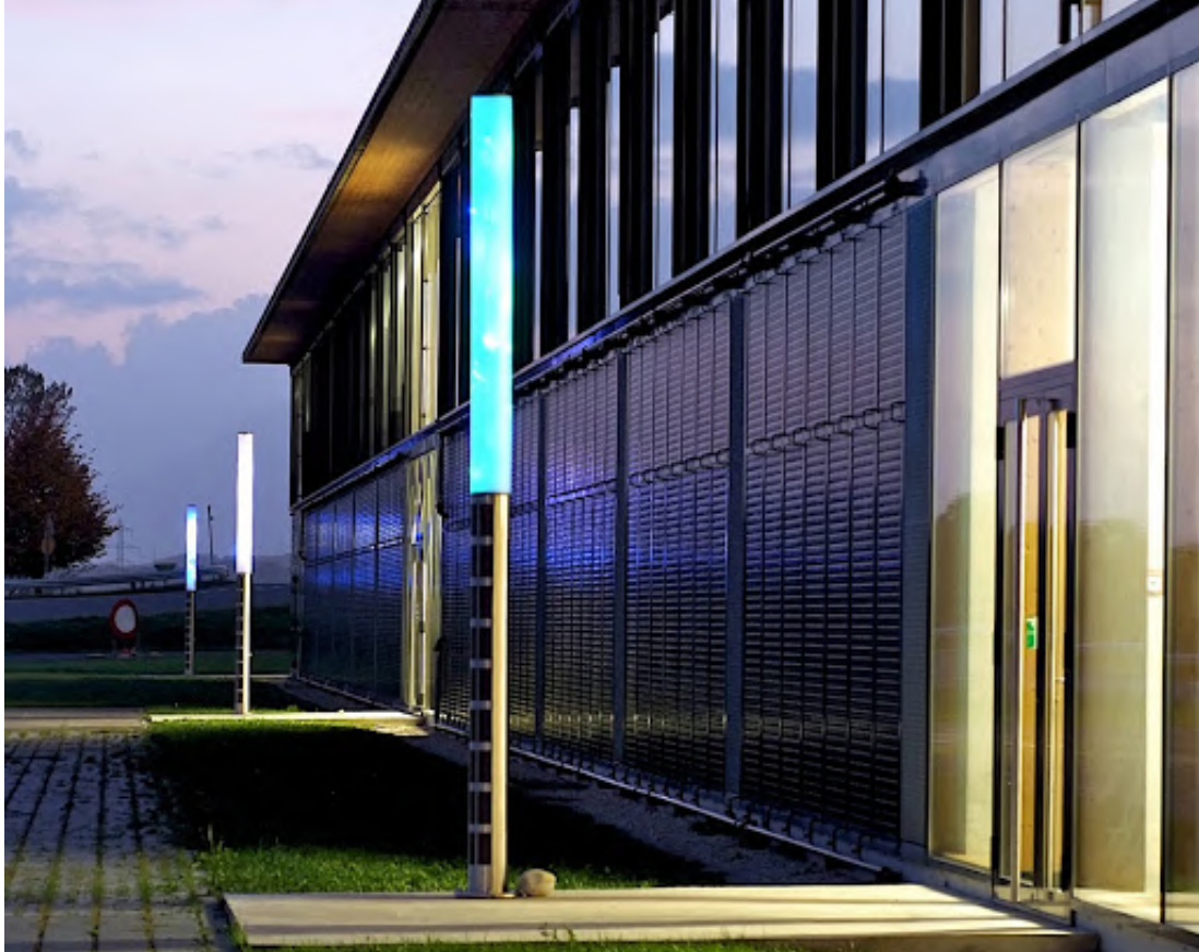
68 Detalle fachada Sur CeRN. [Hatt, Fred]
