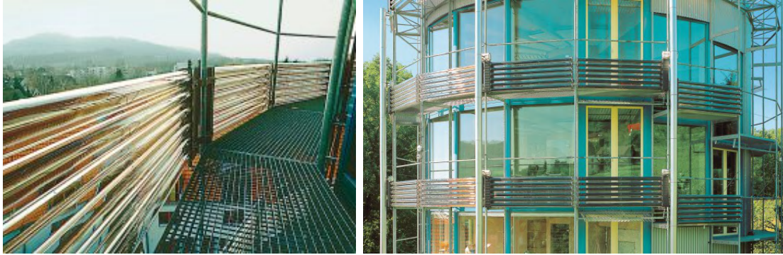
20 Detalle de los colectores térmicos en fachada. Vista del núcleo de instalaciones y escalera. [Rolf Disch]
