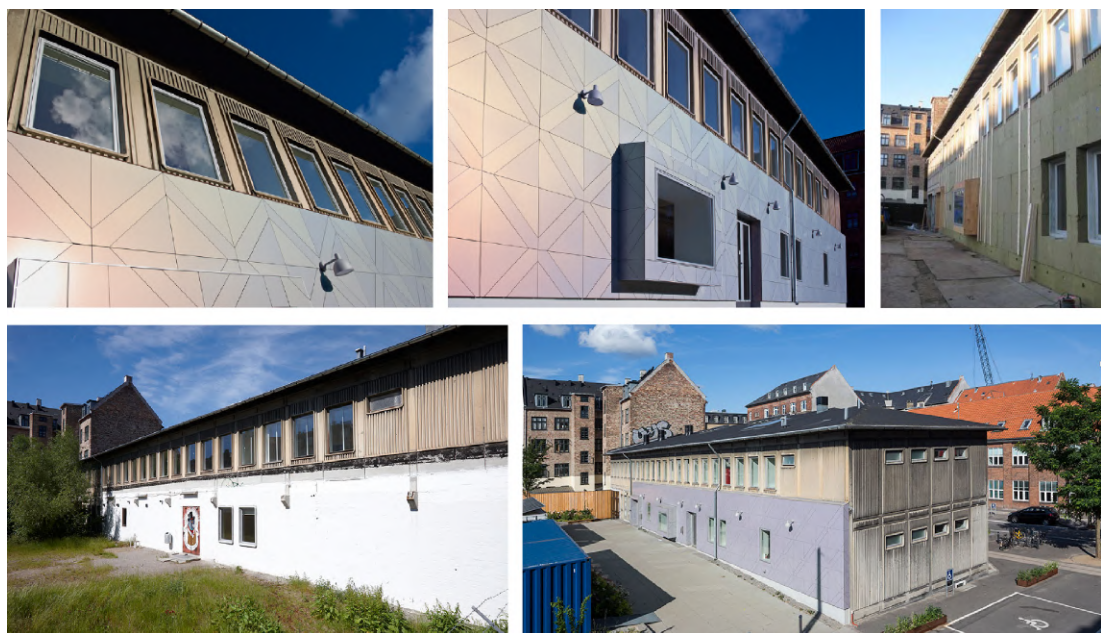
48 Fachada posterior antes y después de la remodelación. Detalle de los paneles Rockwool y Rockpanel Chameleon. [Hiberatlas. Osramhuset]
