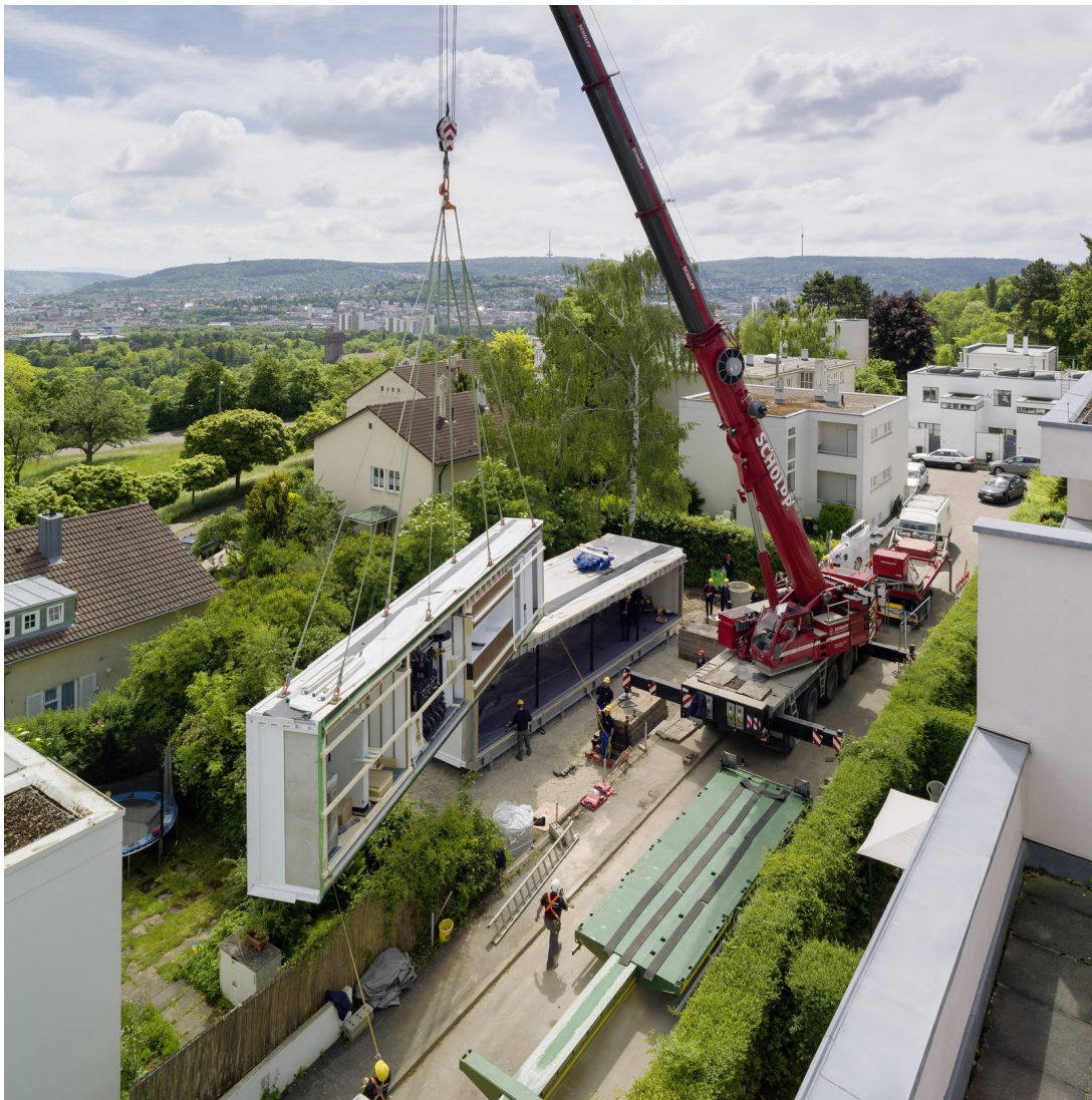
100 Proceso de montaje de las dos piezas de B10. [ArchDaily]
