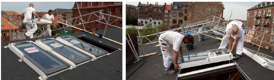
46 Instalación ventanas en cubierta con sistema de protección solar y apertura automatizada. [Velux]
