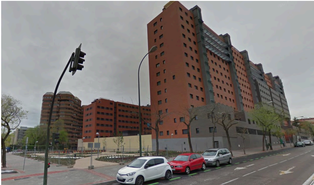
74 Vista del complejo de viviendas EAI 310. [ARCADIS 2017]
