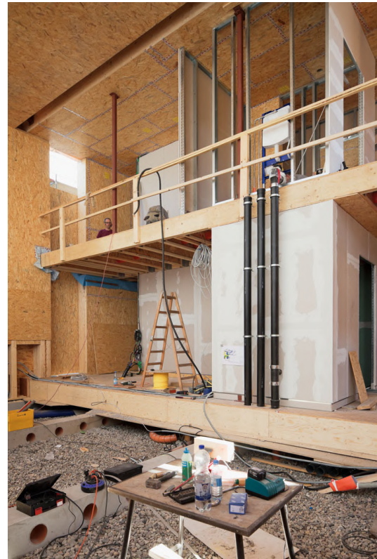
96 Montaje de la escalera prefabricada. Construcción del núcleo tecnológico en el escaparate del edificio. [DBZ]
