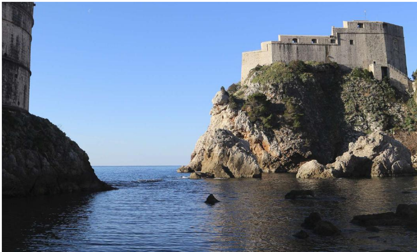
Figura A3.3. Fotografía del Fuerte Lovrijenac desde bahía Kolorina, Dubrovnik (Elaboración propia,2020)
