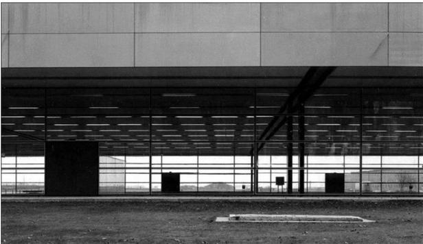
*Figura 26 Parte exterior donde se observa la cornisa de 2 metros elevada sobre la carpintería que recorre de manera igual todos los lados del pabell3n creando un volumen isotropo*
