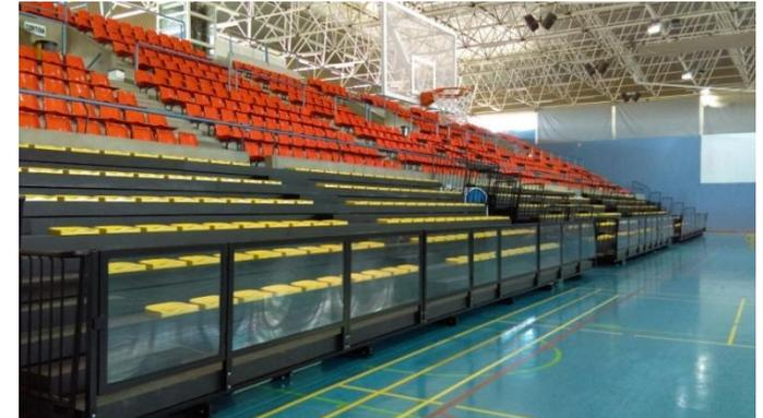
*Figura 10 Ejemplo de grada telescópica y grada fija*
