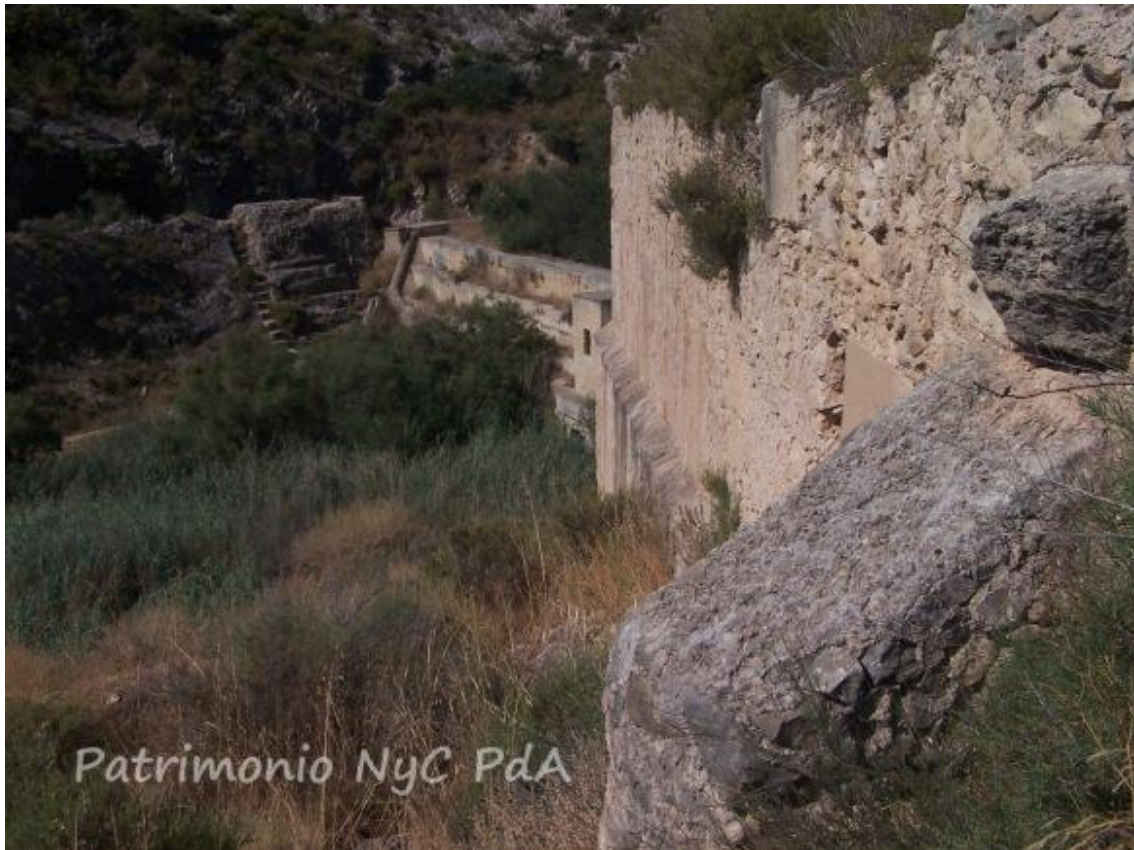
Img.2. Presa actual desde el estribo lateral del muro original. Patrimonio Natural y Cultural de Alicante
