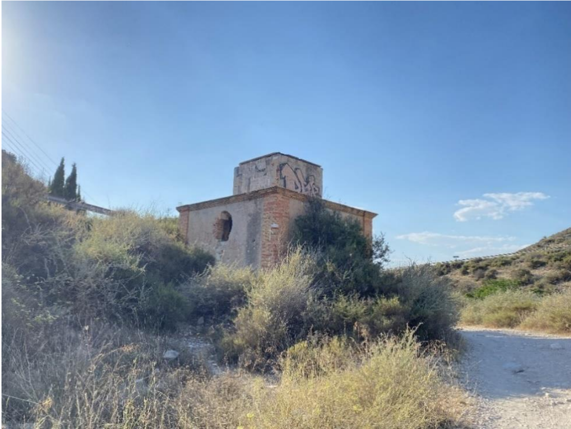
Img.14. El pozo como hito de la ruta. Fotografía propia
