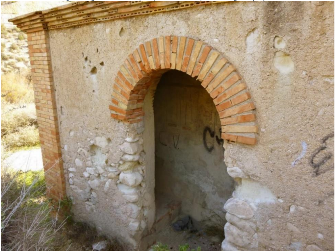
Img.17. Acceso al interior del pozo. Fotografía propia
