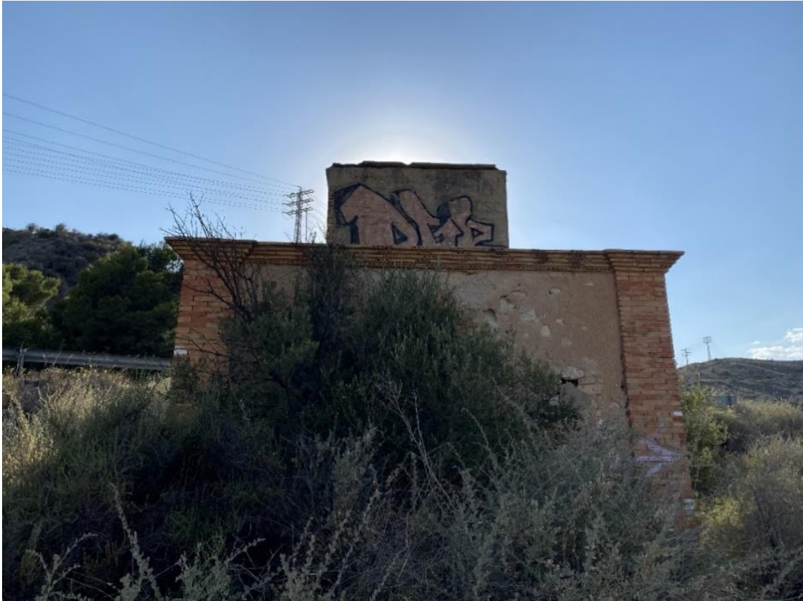
Img.16. Degradación antrópica presente en el pozo. Fotografía propia
