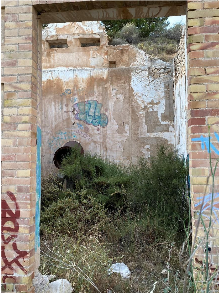
Img.20. Interior prácticamente inaccesible. Fotografía propia
