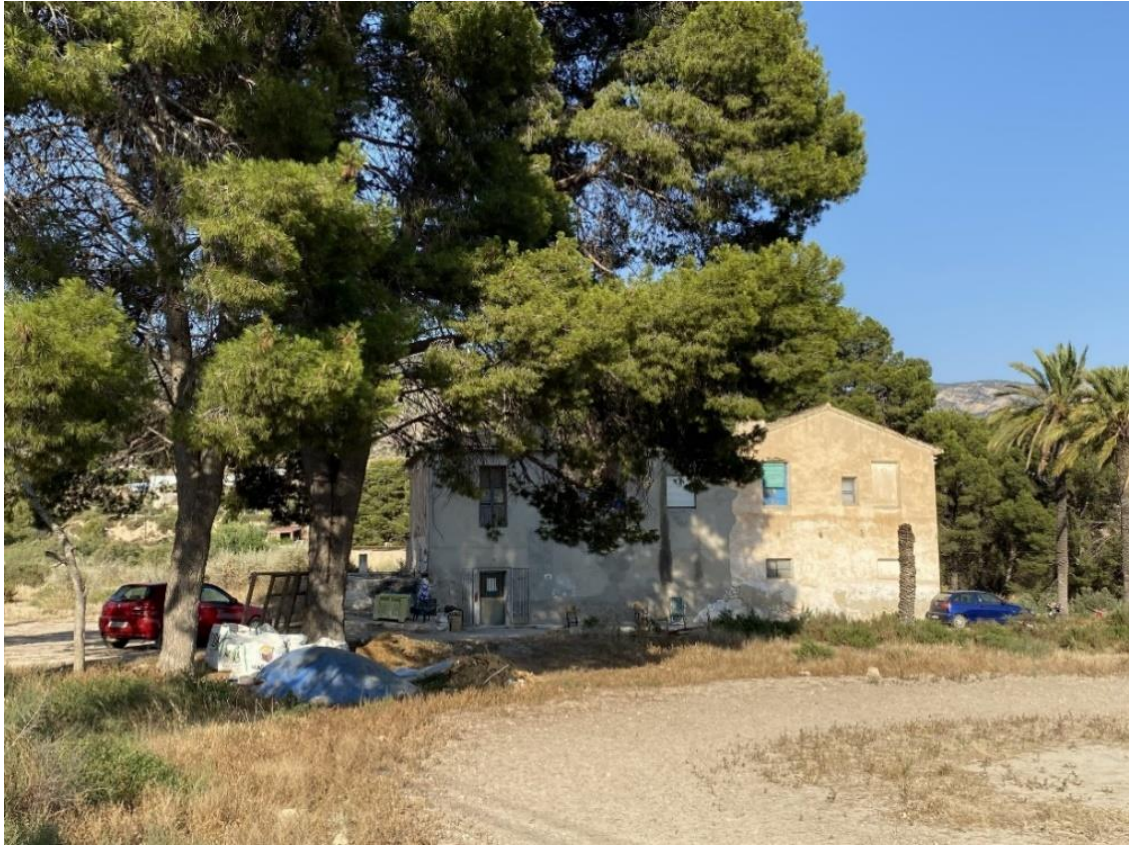
Img.7. Acceso a la vivienda. Fotografía propia
