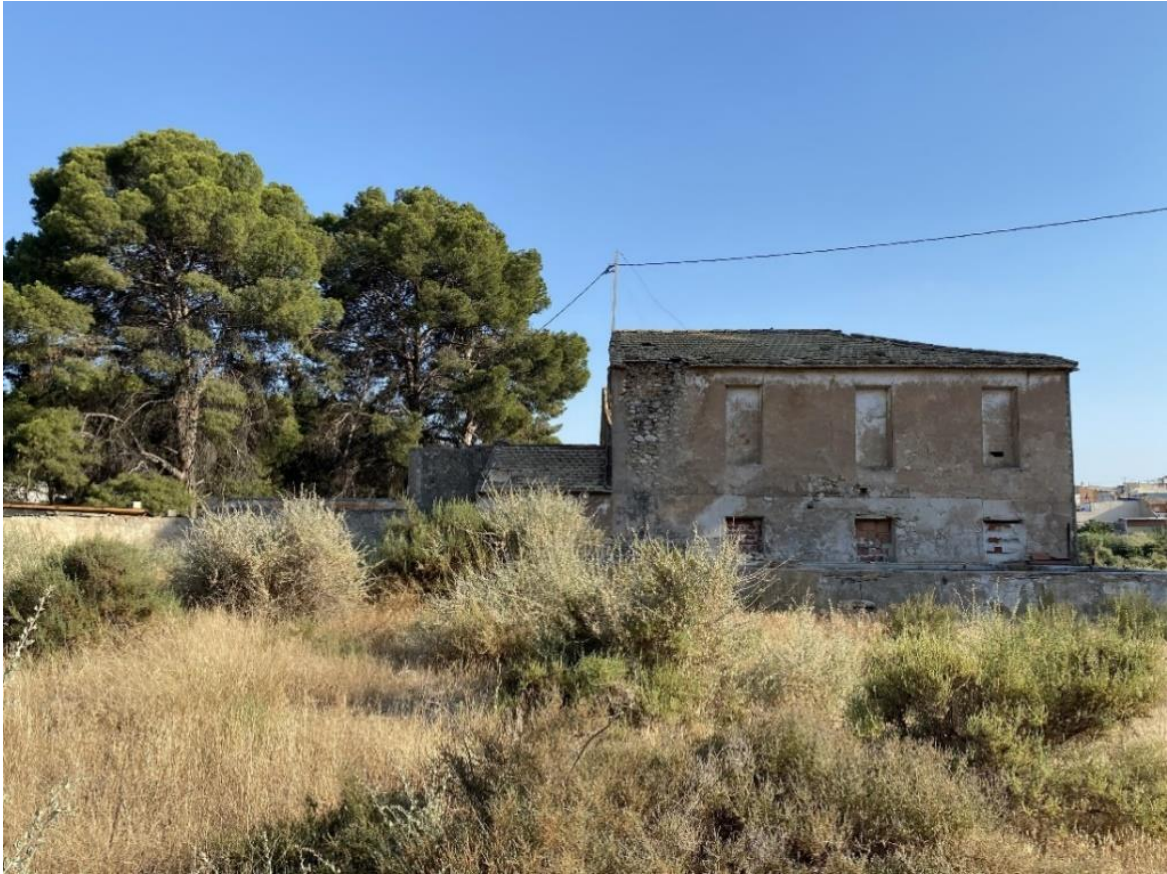
Img.9. Todos los huecos de la fachada norte se encuentran tapiados. Fotografía propia
