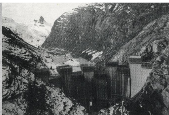
Ilustración 6: Presa de Zervreila.
