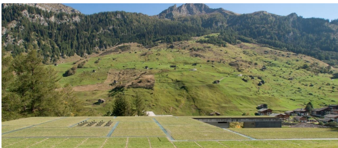
Ilustración 17: Cubierta de las Termas.
