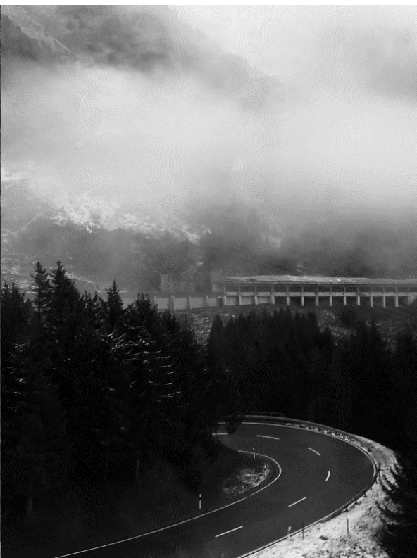
Ilustración 8: Galería de protección.
