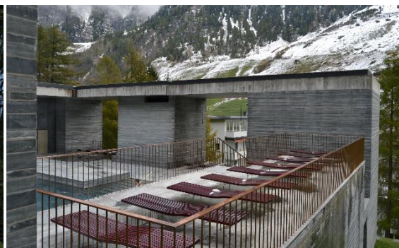
Ilustración 16: Terraza de la fachada sur.
