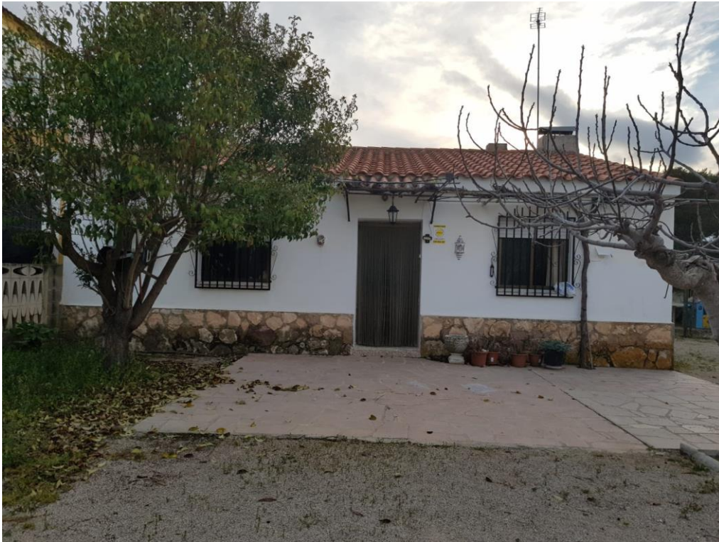
Il·lustración 1: Fachada principal orientación Este. Fuente: Elaboración propia.
