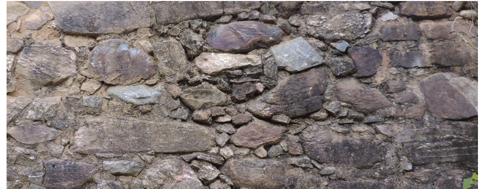
Figura 71. Detalle de la albañilería de la nave. Tomado por el autor, 2020.
