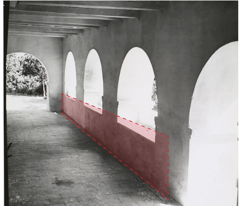
Figura 64. Bancos de albañilería en la arcada del pasillo lateral (Colección IPHAN, 1966). Modificado por el autor a partir de imagen tomada del sitio web del IPHAN- Instituto del Patrimônio Histórico Nacional, 2019.
