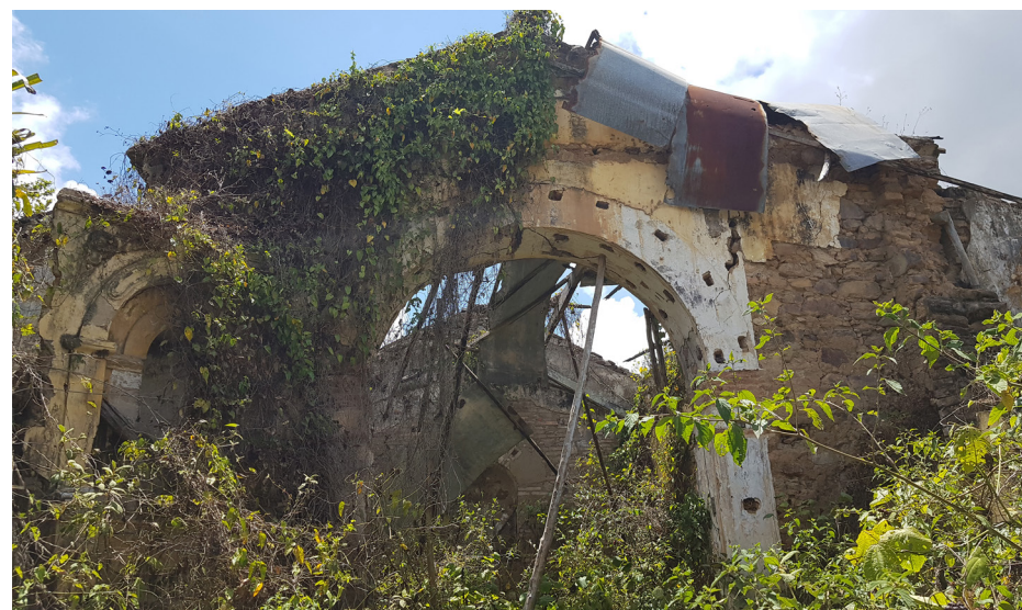
Figura 125. Estado actual del arco crucero y de los altares colaterales de albañilería. Tomado por el autor, 2020.
