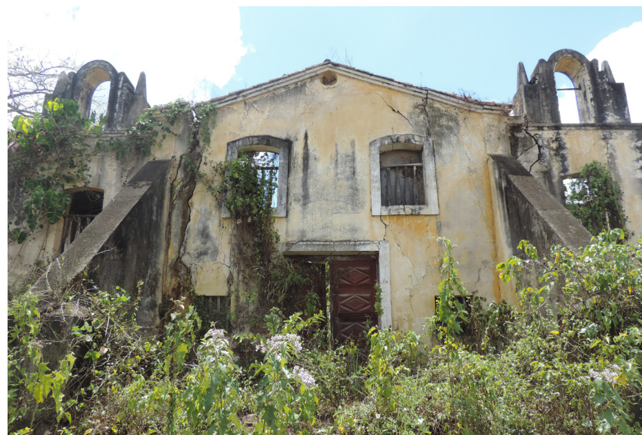
Figura 122. Puerta y barandillas de la fachada principal. Tomado por el autor, 2020.
