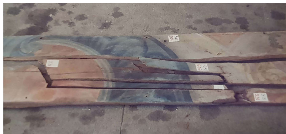
Figura 119. Identificación y encaje de las piezas rotas del techumbre de la nave. Tomado de la colección del IPHAN, 1991.
