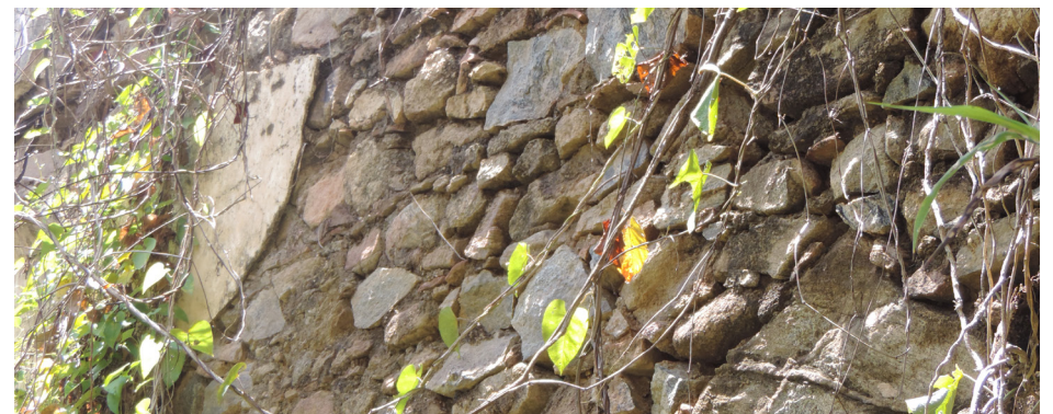
Figura 73. Detalle de la albañilería de la capilla mor. Tomado por el autor, 2020.
