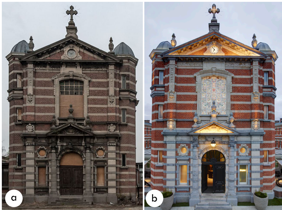
Figura 23. (a).Fachada antes de la intervención, tomada del sitio web www.urbex.nl , 2021. (b) Fachada después de la intervención, tomada del sitio web www.archdaily.com , 2021.
