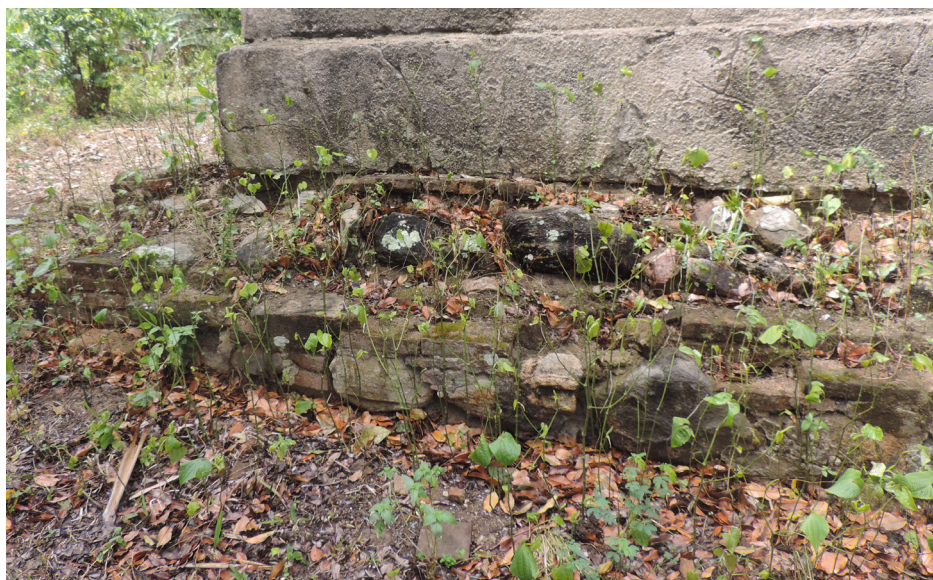
Figura 75. Detalle de la cimentación del Mosteirinho. Tomado por el autor, 2020.
