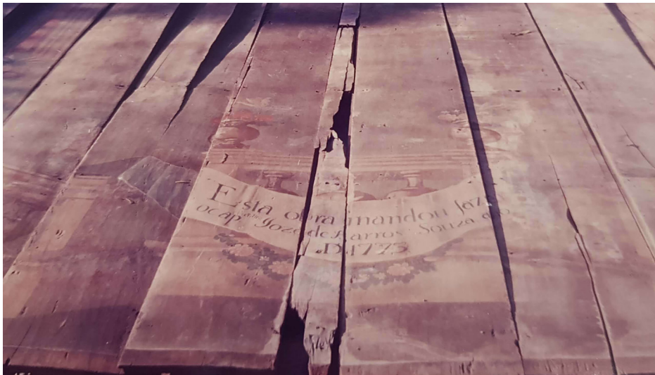
Figura 88. Detalle del techumbre de la nave con la fecha de construcción (Colección IPHAN, 1991). Tomado de la Colección del Archivo General de la 5ª Superintendencia Regional del IPHAN- Instituto del Patrimônio Histórico Nacional, 2019.
