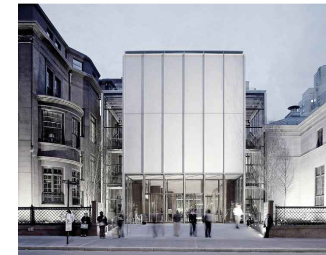
F15| PANELLS D'ACER INOXIDABLE AMB SUPERFÍCIE DECAPADA AMB DOLL DE SORRA, SUBJECTES AMB MUNTANTS OMEGA THE MORGAN LIBRARY & MUSEUM | RENZO PIANO
