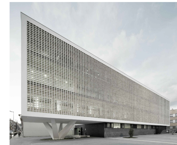
F04| GELOSIA CERÀMICA ARMADA I ESMALTADA DE 190x190 x90mm ACABAT NATURAL ARENA CLS002 FERRÉS CER. CAP PROGRÉS-RAVAL I BAAS ARQUITECTURA
