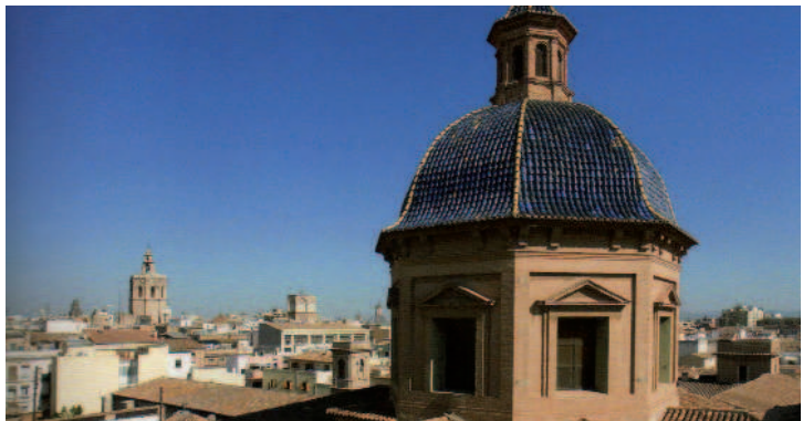
87.- Cúpula del crucero de la iglesia de Santo Tomás de Valencia (Foto Cristina Puig)
