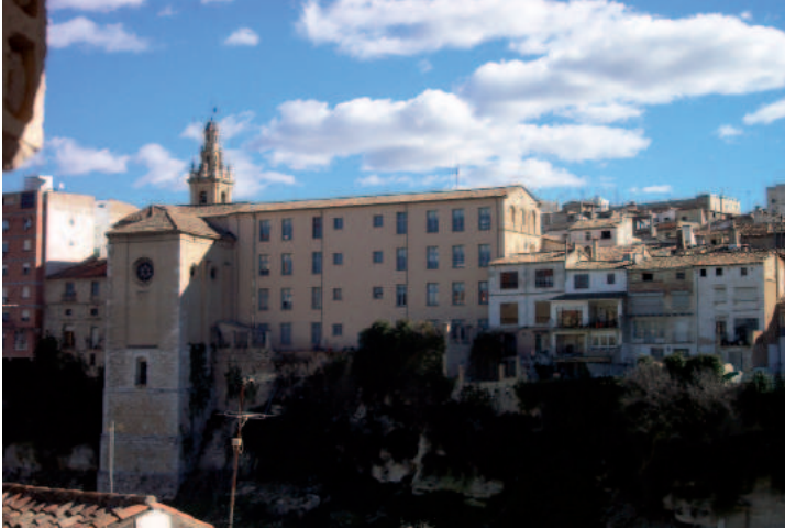
293.- Colegio de Ontinyent. Vista general
