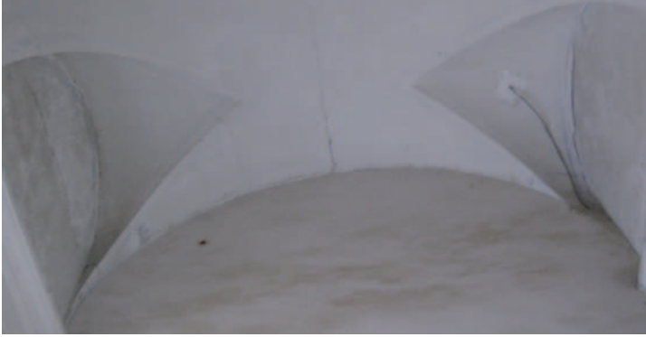
146.- Casa Profesa de Valencia. Bóveda del claustro
