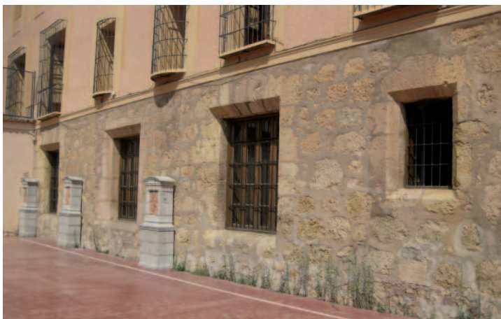
179.- Colegio de Segorbe. Fachada a las antiguas huertas (detalle)
