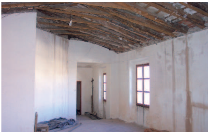
284.- Colegio de Ontinyent. Estancia anexa a la sacristía
