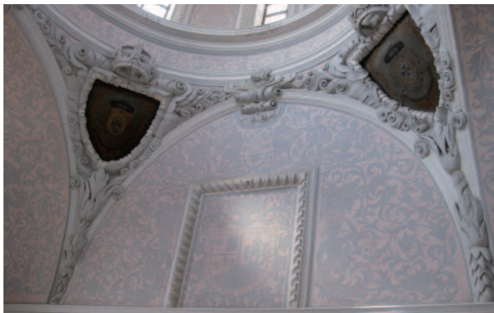
172, 173 y 174.- Colegio de Segorbe. Cúpula de la escalera principal
