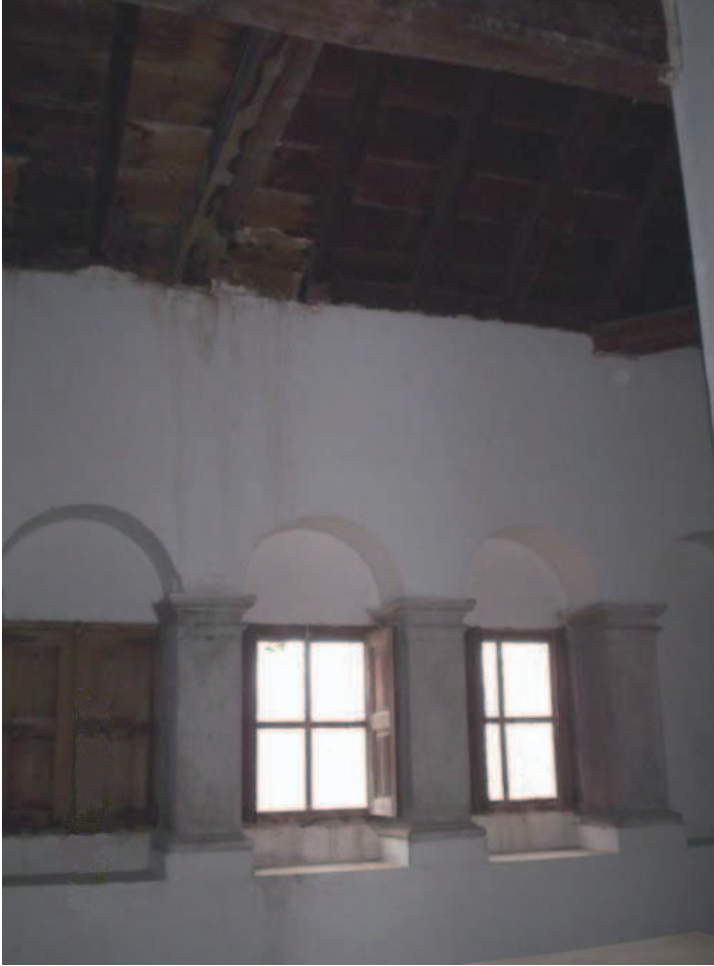
229.- Colegio de Alicante. Interior del antiguo edificio
