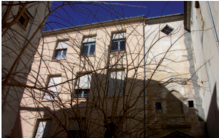
288.- Colegio de Ontinyent. Fachada de la Capilla de Comunión y antiguas escuelas
