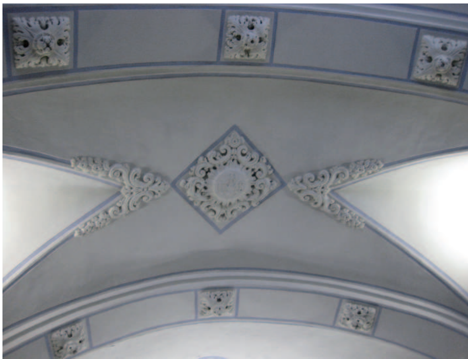
163.- Colegio de Segorbe. Bóveda de la sacristía
