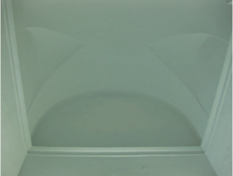
73.- Iglesia de la Universidad de Gandía. Bóveda del tramo de acceso
