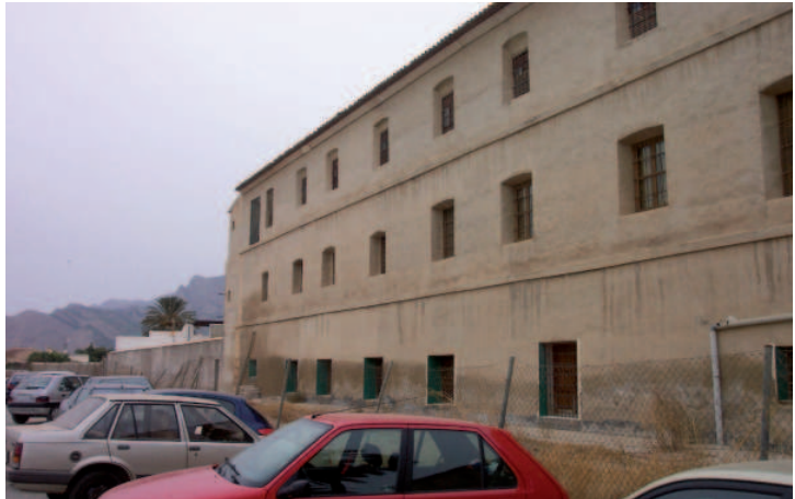
248, 249 Y 250.- Colegio de Orihuela. Antiguo Edificio
