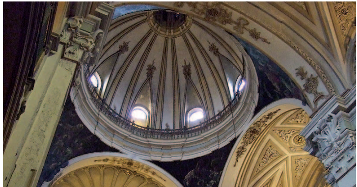
29.- Iglesia del Colegio de Calatayud. Interior
