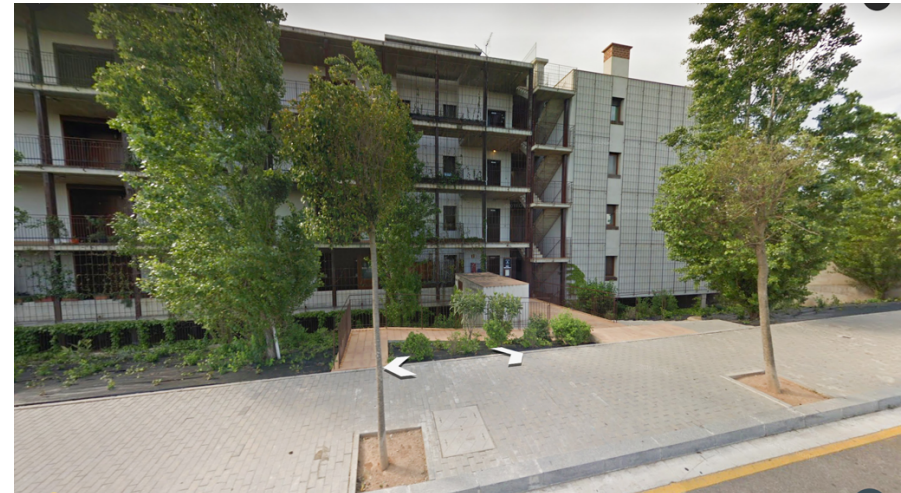
Imagen 54_ Identificación de elementos desde la calle.
