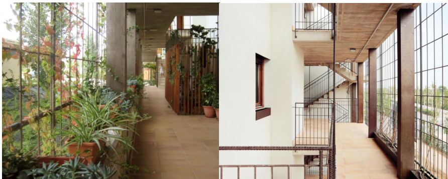
Recordatorios imágenes 49 y 50_ Corredor en planta baja y corredor en plantas superiores.
