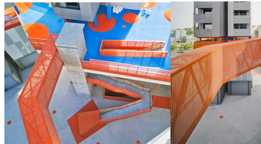
Conjunto imágenes 62_ Pasarela de transición a la plaza elevada desde la torre exenta a la plaza.
