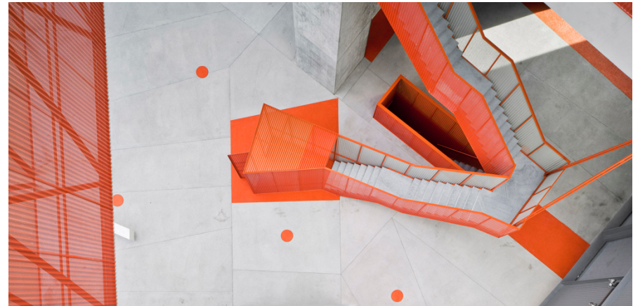
Imagen 64_ Puntos naranjas del suelo y placas indicadoras de comunicación vertical y accesos.
