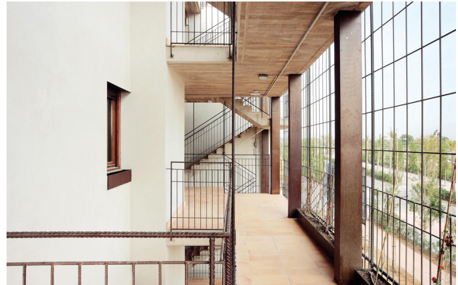
Imagen 50_ Corredor de plantas superiores. La fotografía es antigua y no se puede apreciar el crecimiento de la vegetación en las mallas.
