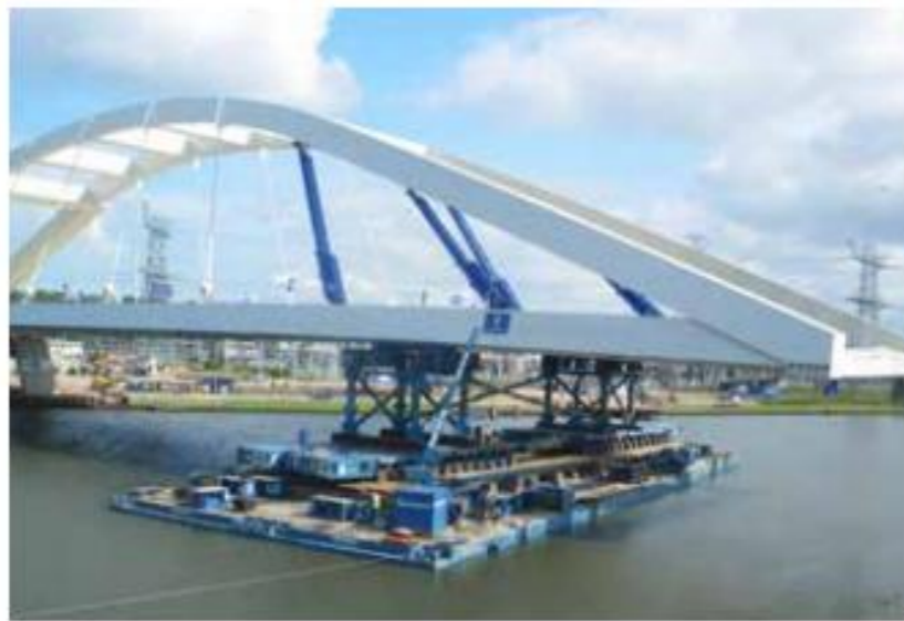
Figura 4 – Ejemplo de barcaza de la empresa SARENS (fuente: (SARENS, 2021))
