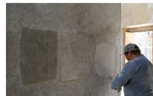
Figura 9.23 Aplicación de muestras sobre repellido de cal, 2017
