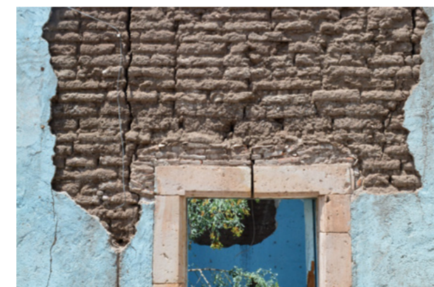
Figura 6.6 Degradación de cuerpo de muro derivado de la acción del lavado de la lluvia y la erosión del viento, capilla de la hacienda La Primavera, Aguascalientes, 2015
