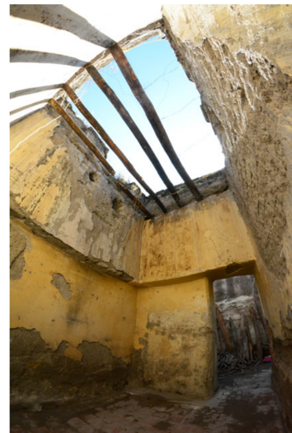
Figura 9.13 Retiro de cubierta parcialmente colapsada y limpiezas en general, 2016
