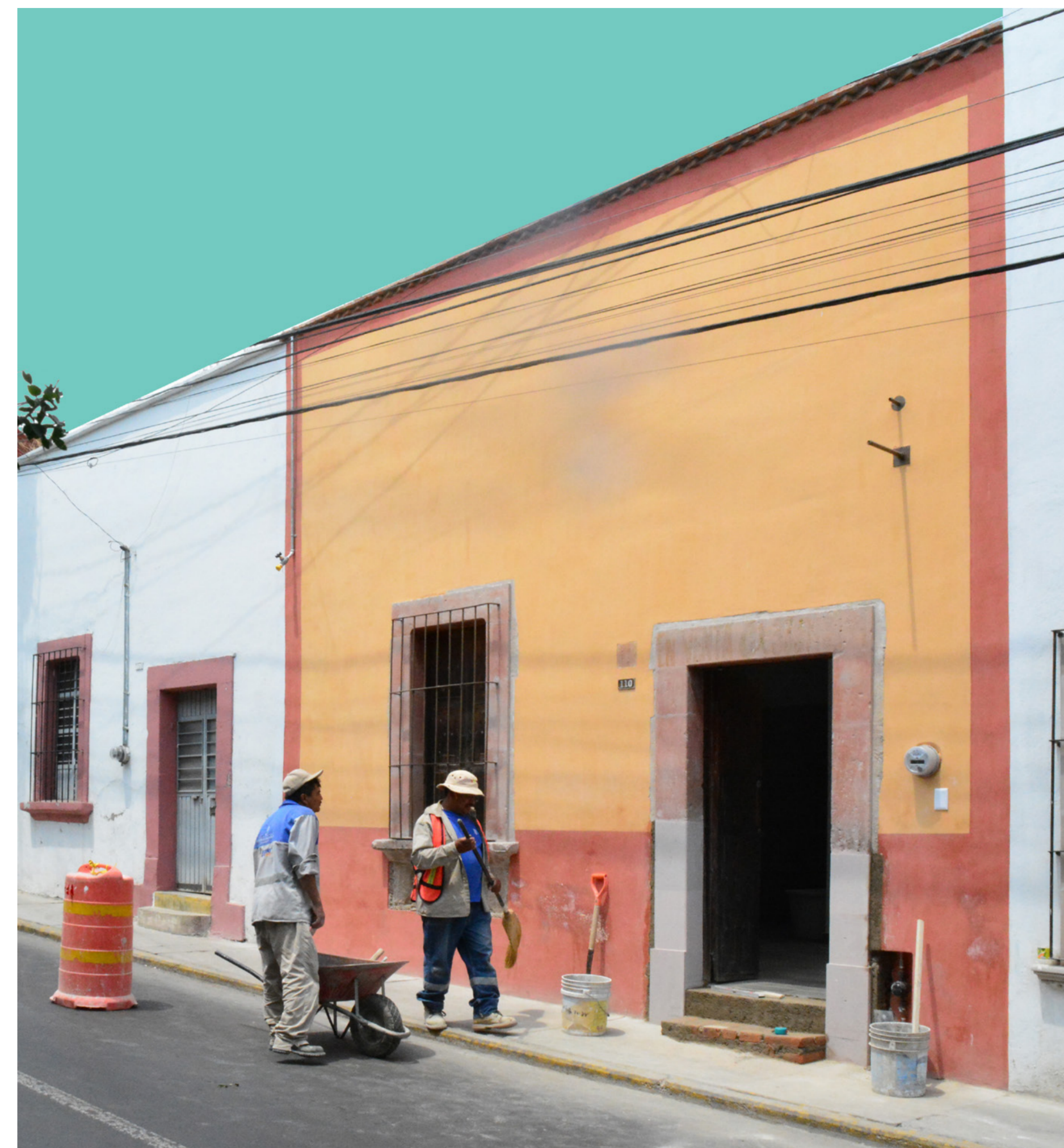
Figura 9.29 Fachada, después de la intervención, 2017
