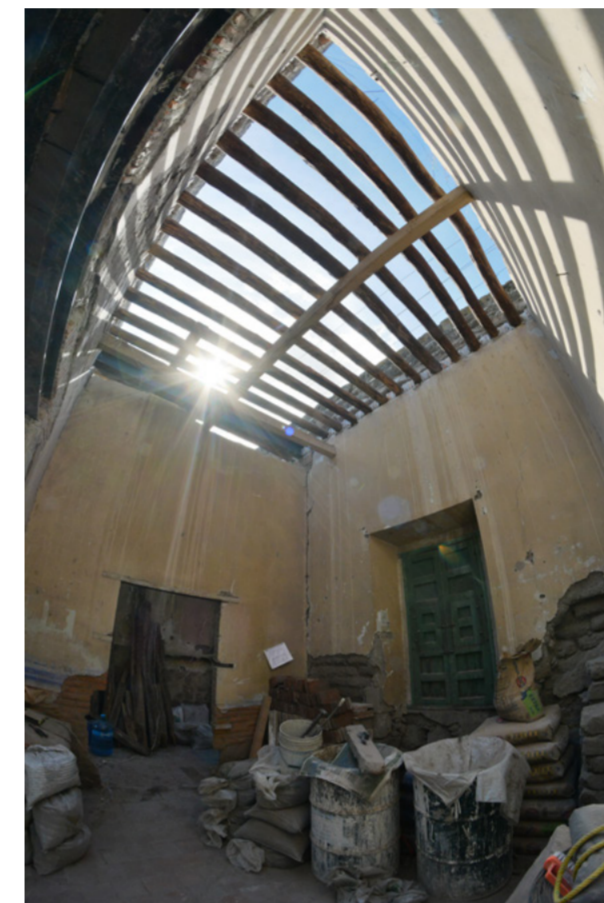
Figura 9.17 Proceso de recuperación de cubierta I, 2017
