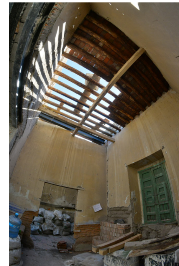
Figura 9.18 Proceso de recuperación de cubierta II, 2017
