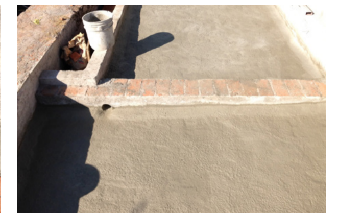
Figura 9.22 Enlucido sobre enladrillado para cerrar el poro del ladrillo, 2017
