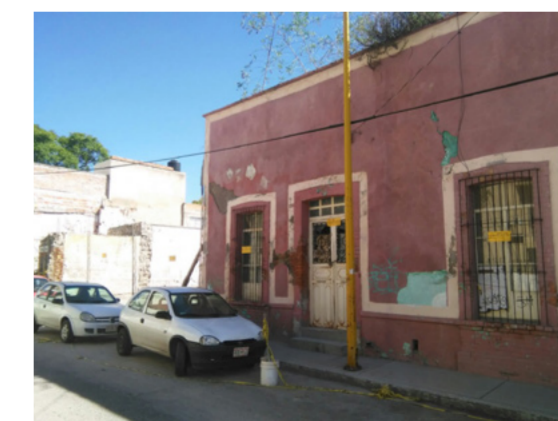
Figura 6.16 Inmuebles tradicionales en proceso de demolición, 2015
