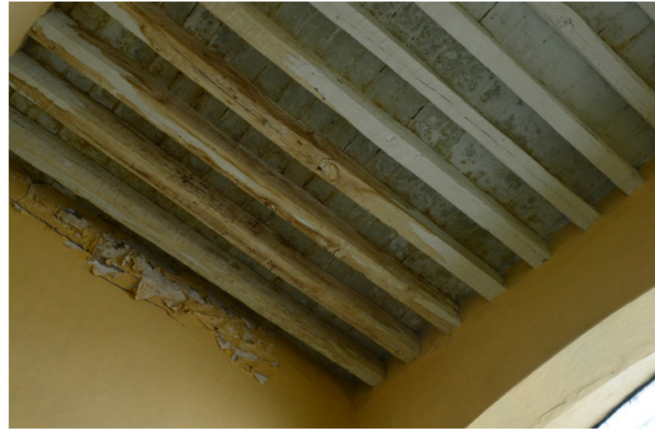
Figura 6.9 Presencia de humedad en cubierta, allende 305 [Inmueble perdido], 2015. Se puede notar el cambio de coloración en la superficie, así como la flecha de los elementos.
