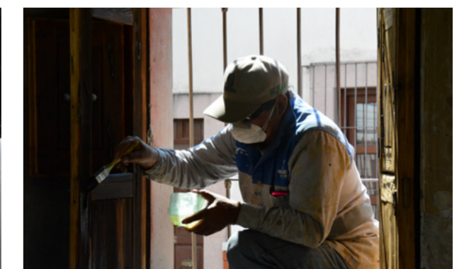
Figura 9.25 Aplicación de tratamiento en carpinterías, 2017
