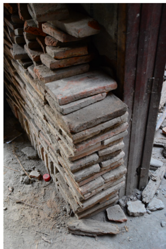
Figura 9.11 Recuperación y acopio de ladrillo de cubierta para su posterior utilización, 2016
