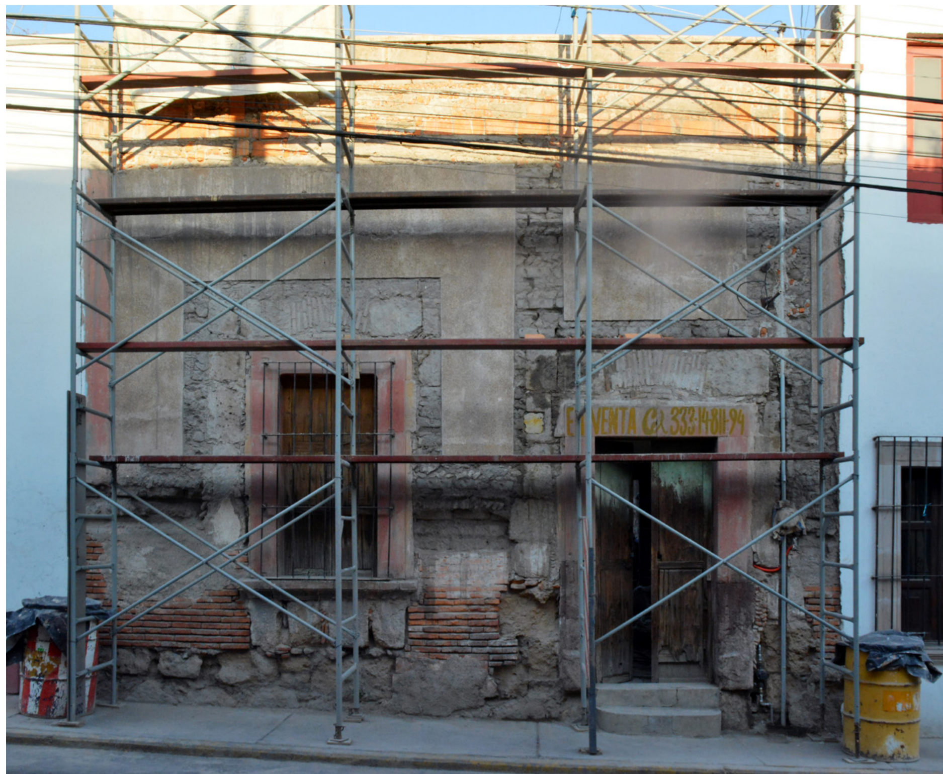
Figura 9.26 Intervención de fachada, programa Rescatando nuestra arquitectura del Municipio de Aguascalientes, 2017
