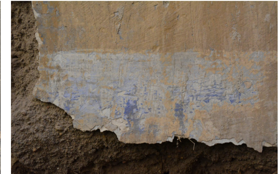
Figura 9.10 Revoco y pintura de cal.
