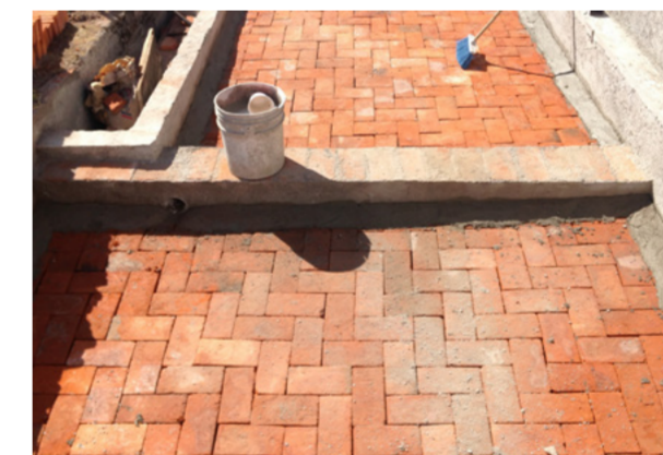
Figura 9.21 Enladrillado de cubierta, 2017
