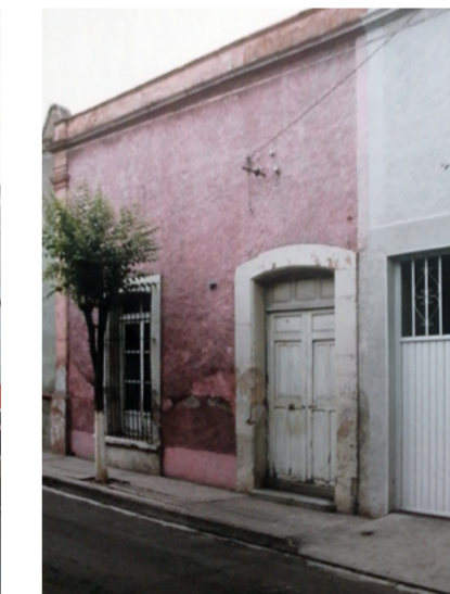
Figura 6.25 Vivienda ubicada en Juan de Montoro 325 y 327, AFINAH AGS, 1989
