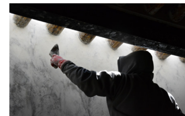
Figura 9.24 Aplicación de masilla de cal sobre repellido, 2017
