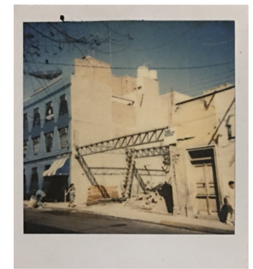
Figura 6.26 Inmueble ubicado en Díaz de León 104, demolido para dar paso a un comercio, AFINAH AGS, 1993
