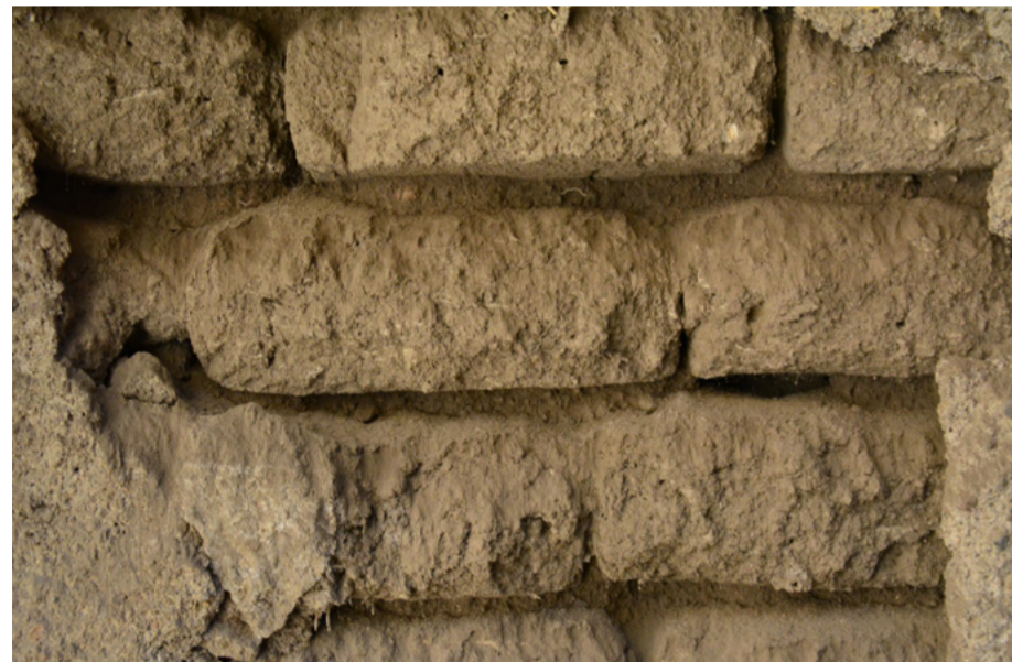
Figura 9.5 Muro de adobe 10,42,63, asentado en 63 cm
