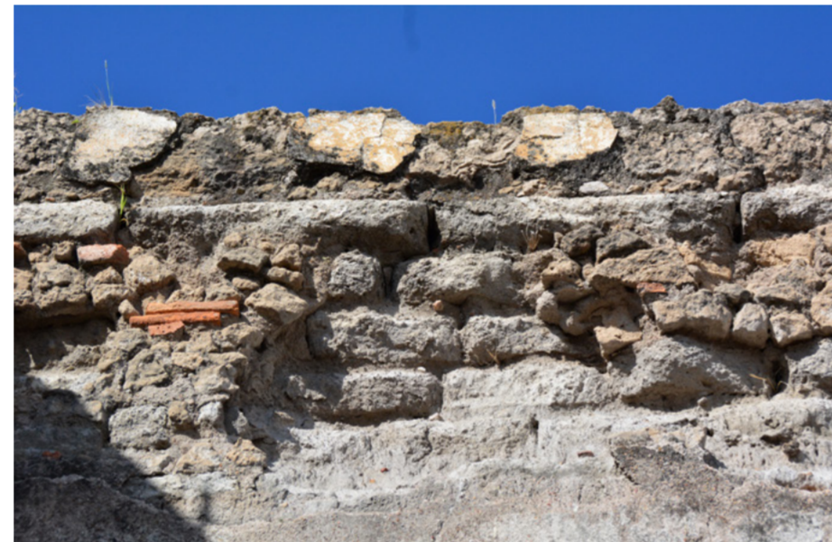
Figura 9.6 Corona de muro fabricada con piedra maticán.
