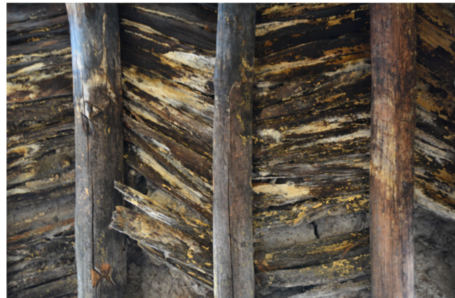
Figura 9.8 Cubierta de rollizo de madera y tableta en espina de pez.
