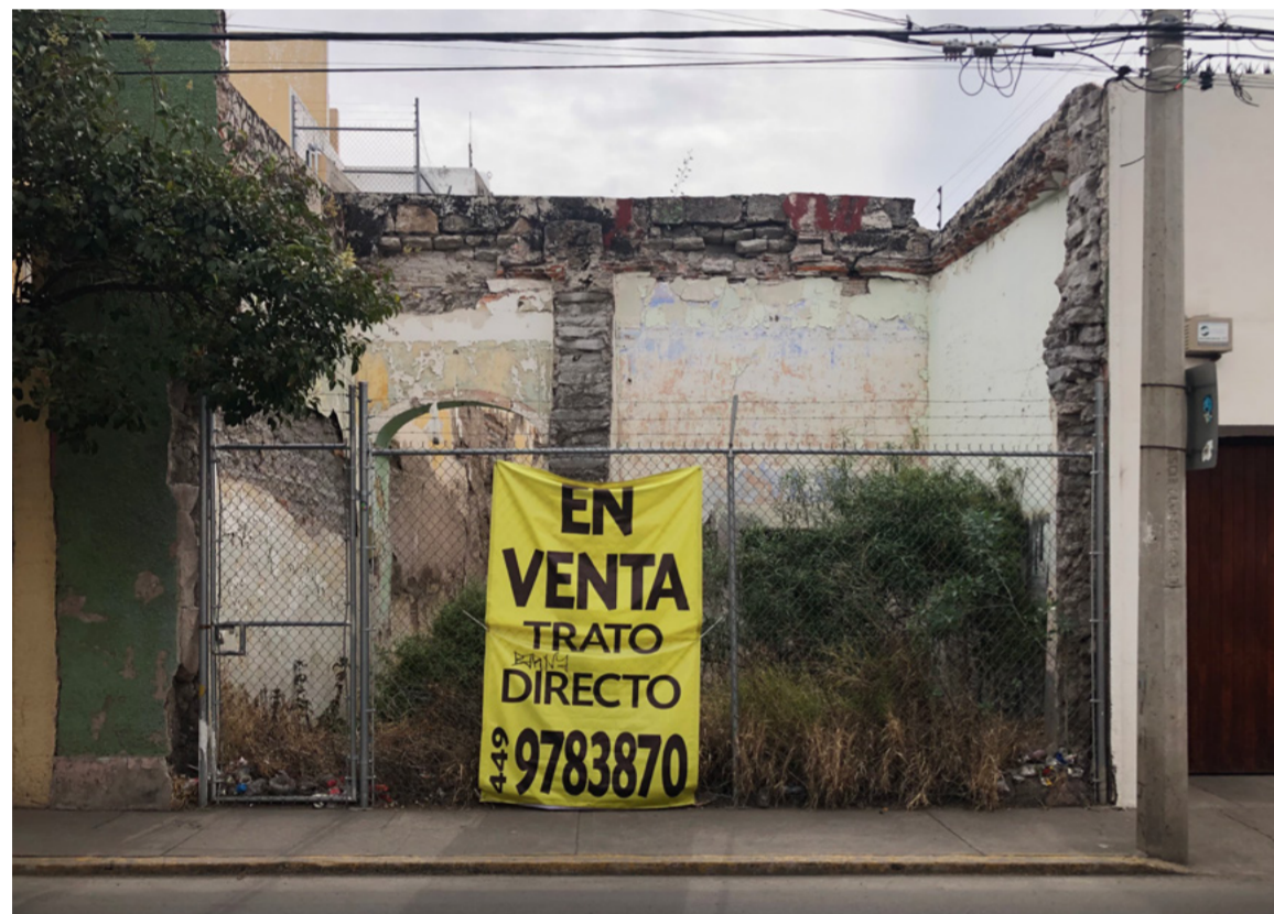
Figura 6.22 Demolición de fachada del inmueble para su comercialización, Juan de Montoro 311 [Inmueble perdido], 2020. El inmueble, contaba con todas las características representativas del siglo XIX, muros, cubiertas, enmarcamientos de cantería e incluso pintura decorativa.
