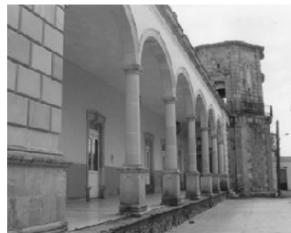
Figura 3.4 Casa grande, ex hacienda de Cañada Honda, sin autor, ca 1920
