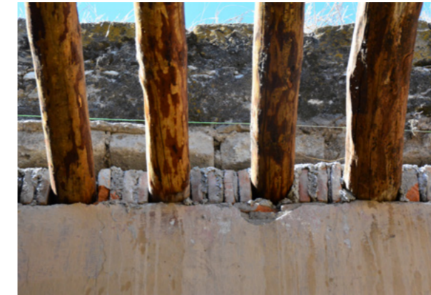
Figura 9.14 Reposición de morillos y reconstrucción de mechinales, 2017
