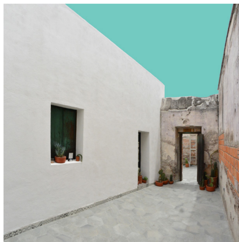
Figura 9.27 Primer patio, después de la intervención, 2018
