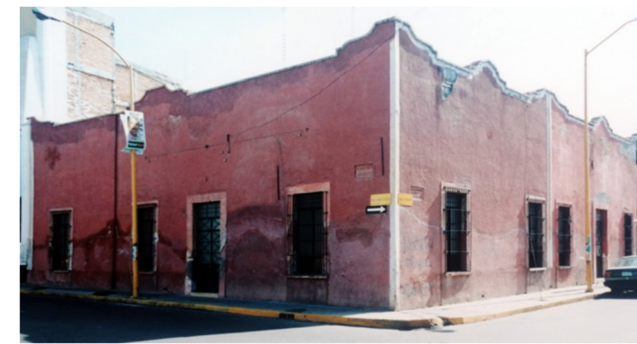
Figura 6.27 Inmueble ubicado en Hidalgo esquina Juan de Montoro, AFINAH AGS, 1998
