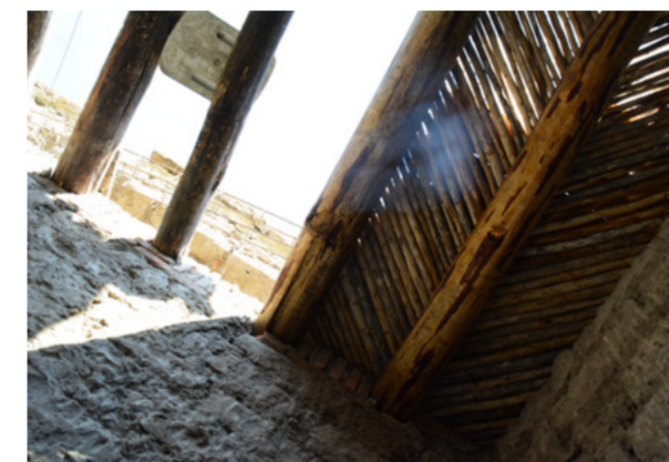
Figura 9.20 Proceso de recuperación de la cubierta con tableta en espina de pez, 2017
