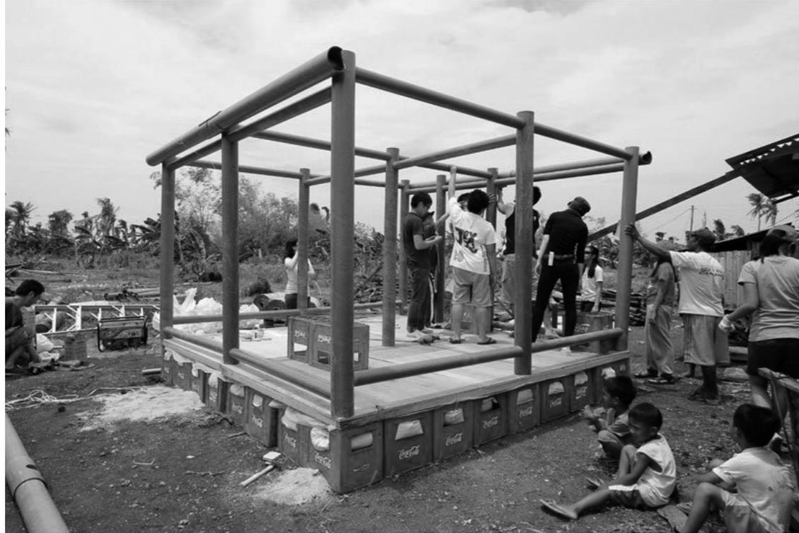
Fig. 19 Fotografía proceso constructivo Paper Log House
