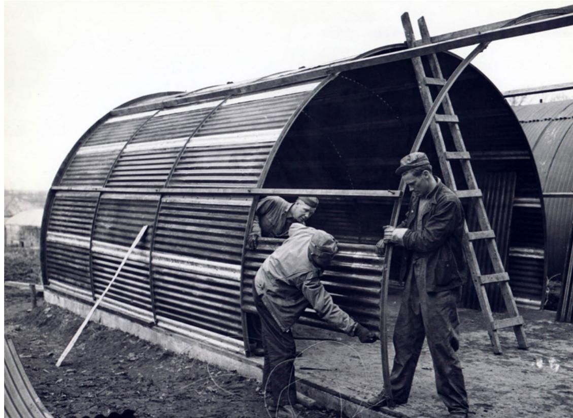
Fig.05 Fotografía de la construcción modelo Quonset Hut 20'x48'
