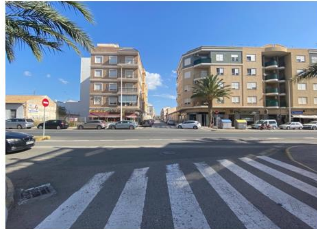
Imagen 14. Incorporación a la travesía desde C/ Araceli, gasolinera a la izquierda (Fuente: Elaboración propia)
