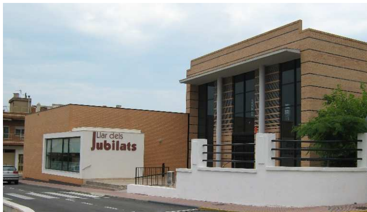
Figura 5.3. Edifici Llar dels Jubilats.
