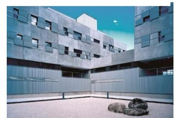
Imagen 45. Cerramiento exterior de paneles prefabricados de hormigón
