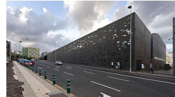
Espacio de las Artes - Herzog & de Meuron (Muro de hormigón prefabricado perforado)
