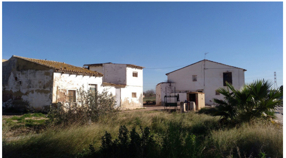
Figura 186. Imagen del estado actual del elemento 15. Molí de l'Ascensió, 2019
