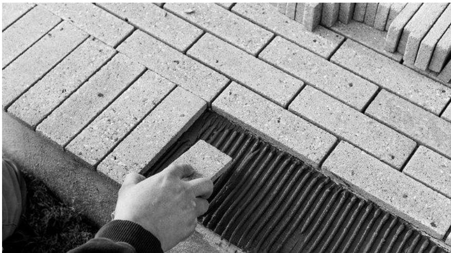
Figura 49: Aplicación en obra baldosas de Biocemento como pavimento. (BIOMASON 2020)
