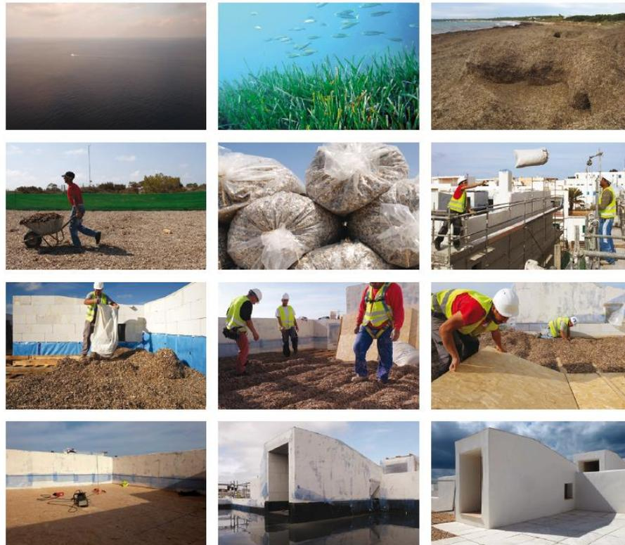
Figura 32: Proceso de recogida, transporte y aplicación en la obra del proyecto (LIFE REUSING POSIDONIA 2018)
