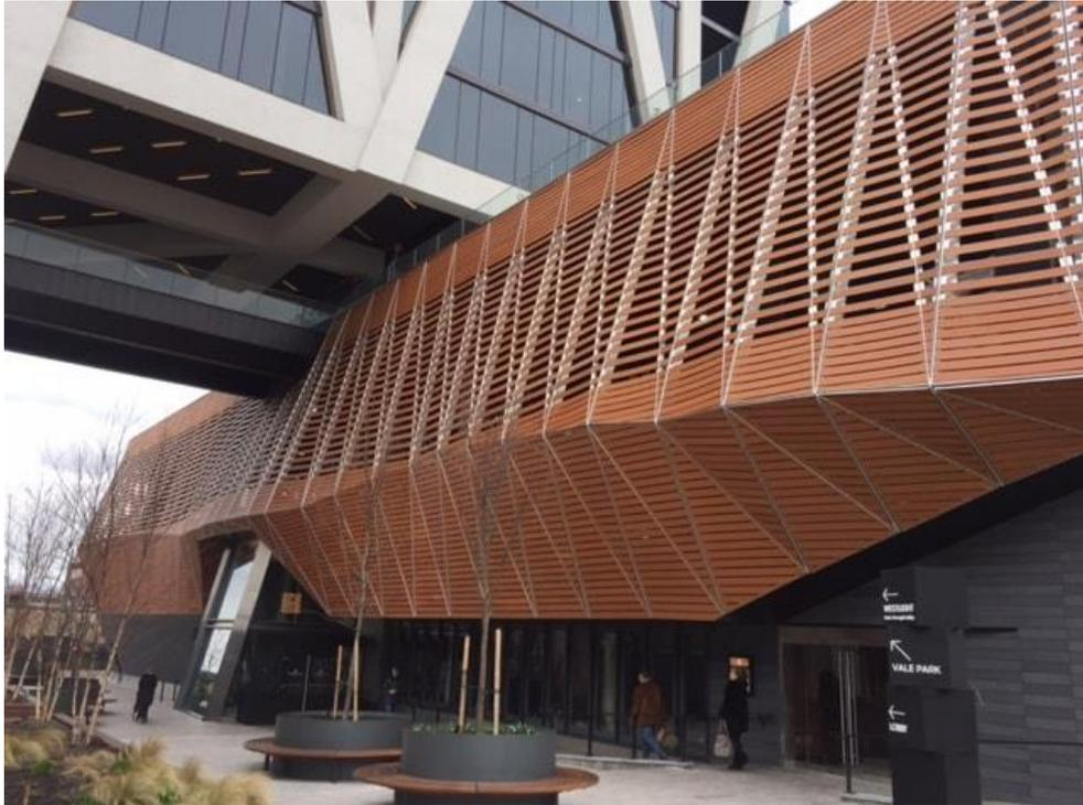
Figura 51: Ejemplo fachada revestida con lamas de Resysta. (RESYSTA GmbH 2018)
