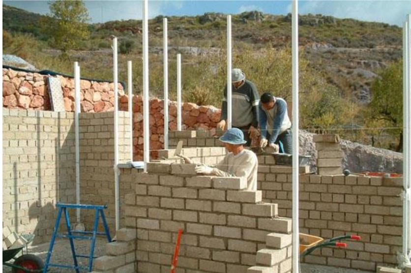
Figura 39: Proceso construcción de cerramiento vertical con ladrillos Cannabrick en vivienda unifamiliar (Brümmer n.d.)
