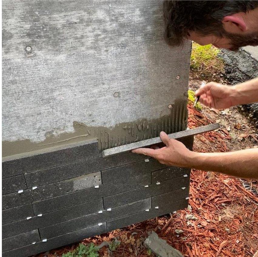
Figura 50: Aplicación en obra baldosas de Biocemento como revestimiento pared exterior(BIOMASON 2020)
