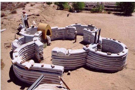
Figura 9: : Proceso de construcción técnica Superadobe
