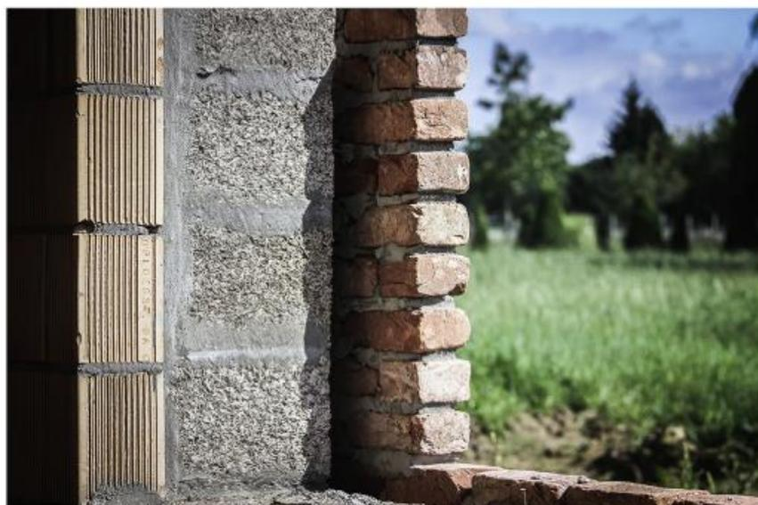
Figura 54: Ejemplo de aplicación como aislante en cerramientos exteriores (IsoHemp, 2019)
