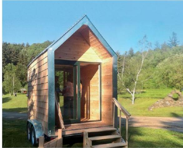
Figura 57: Mushroom Tiny House, 2013 y detalle cerramiento. Casa ecológica con las paredes aisladas mediante el uso de Greensulate creada por Ecovative Design. (Hebel, Wisniewska, and Heisel 2014)
