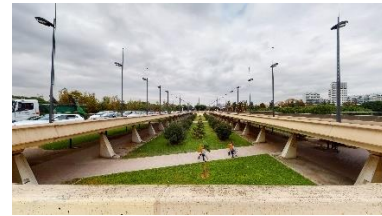
Daños por zonas
