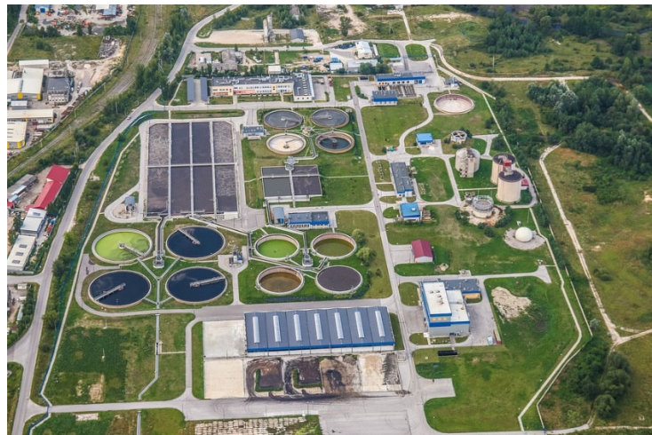
Figura 1. Estación Depuradora de Aguas Residuales. Fuente Michal Jarmoluk-Pixabay.
