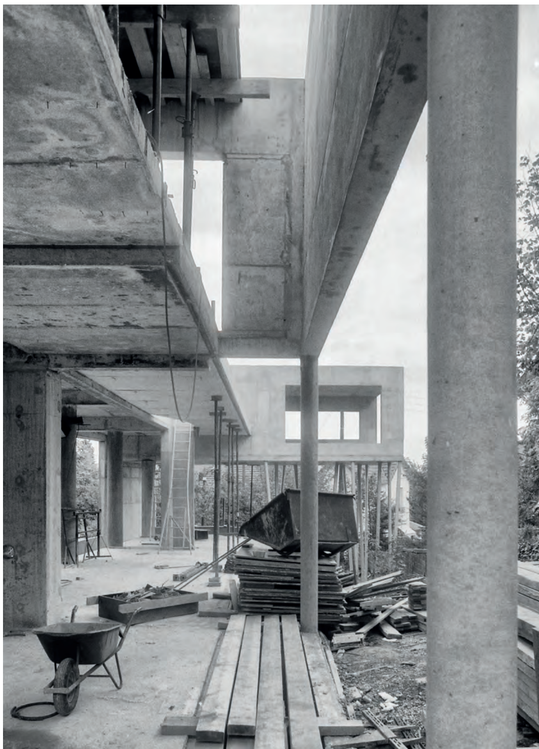
Villa Dall'Ava. La vivienda en fase estructural. Vista desde el futuro salón hacia la calle. © Archivos Hans Werleman
