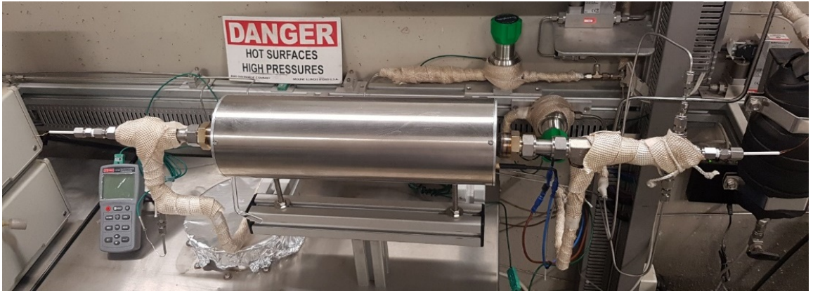
Figura 8.8. Detalle del montaje del reactor de membrana de alta presión dentro del sistema de reacción de alta presión.
