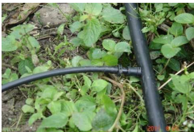
Figura 51. Alimentación de líneas de goteo
