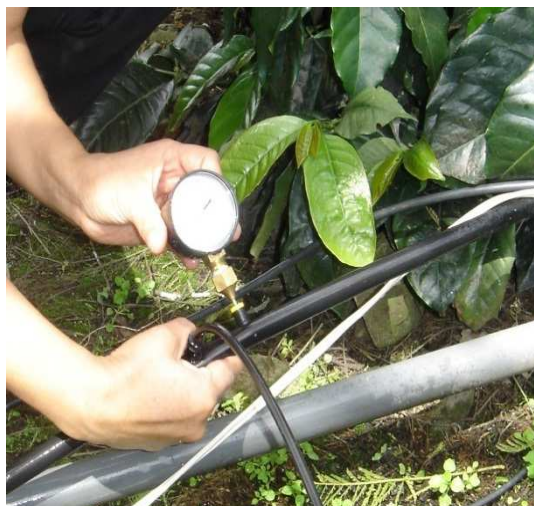
Figura 31. Medida de la presión del agua utilizando un manómetro
