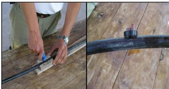
Figura 28. Conexión de goteros integrados (Liotta M.)
