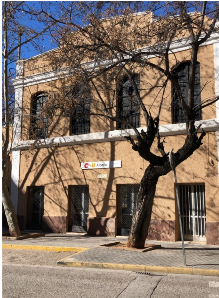
Ilustración 32: Estación de metro de Alberic (Fuente: Elaboración propia)
