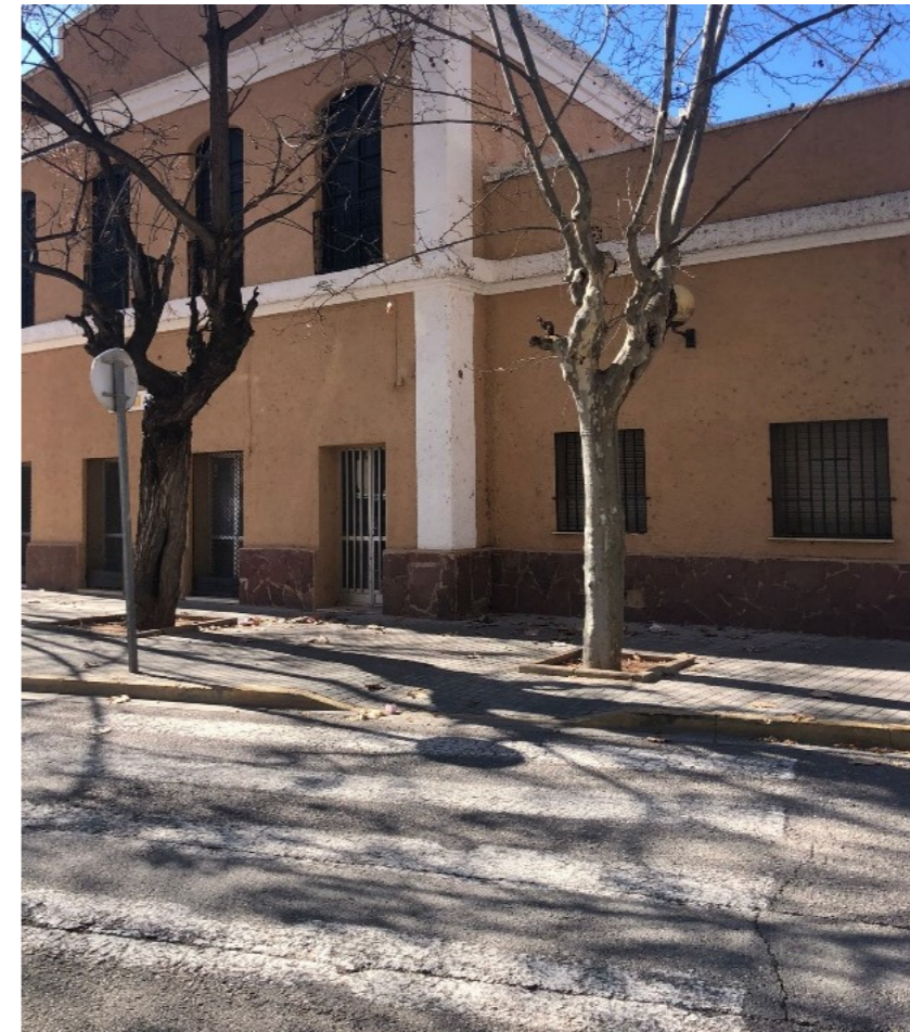
Ilustración 45: Movilidad accesible en la estación de metro (Fuente: Elaboración propia)
