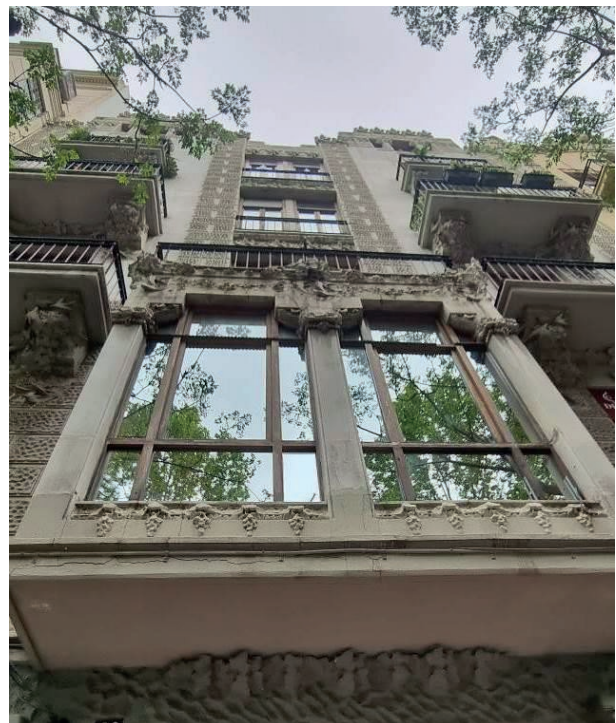
Fig. 12 Facade. At 40 Gran Vía Marqués del Turía Valencia. (Source: the author).
