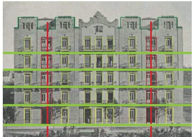
Fig. 11 Composition of the facade of the 3 buildings. At 36, 38 and 40, Gran Vía Marqués del Turía, Valencia. Source: Arquitectura y construcción .
