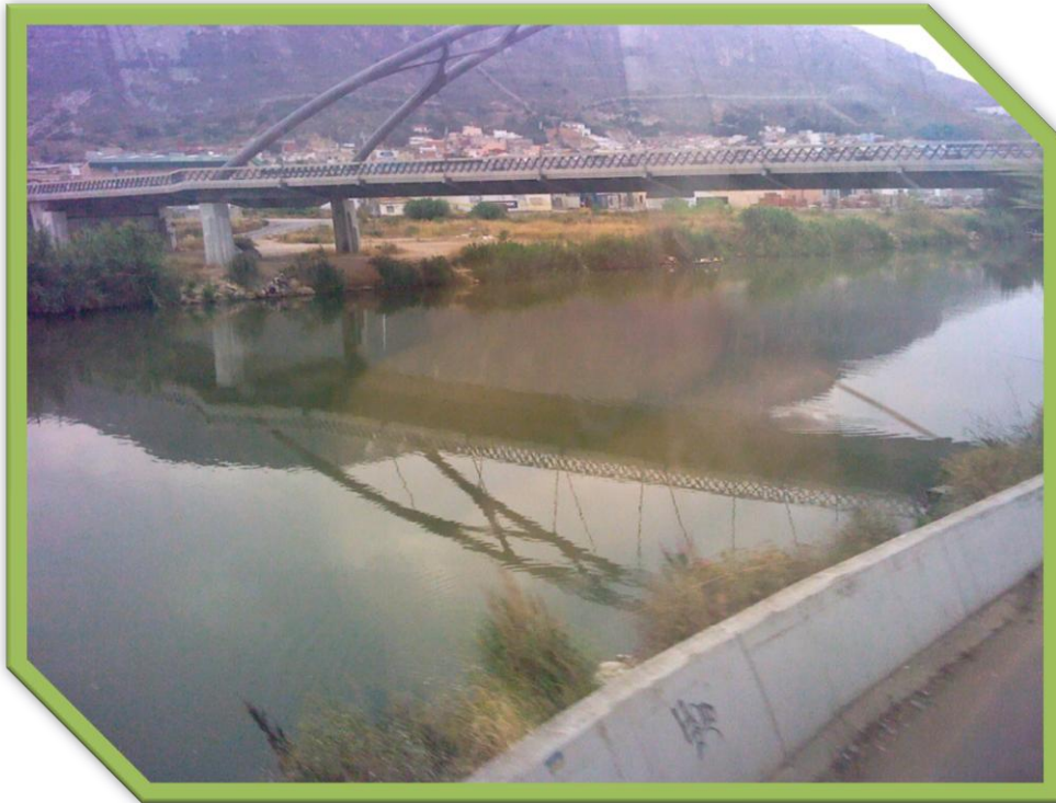
Puente ubicado en Cullera.
