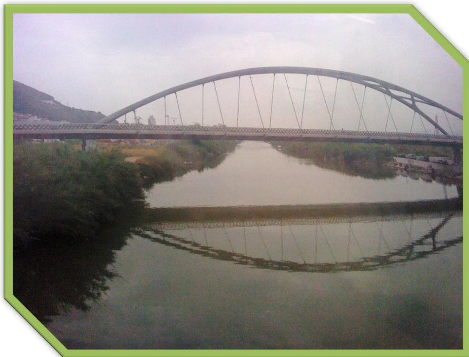
Puente ubicado en Cullera.
