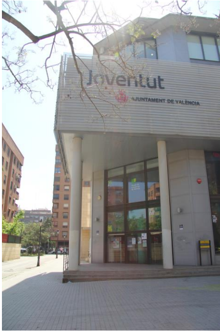
Fig. 42 Edificio Joventut. Espai Jove (Calle Campoamor, 91) Valencia
