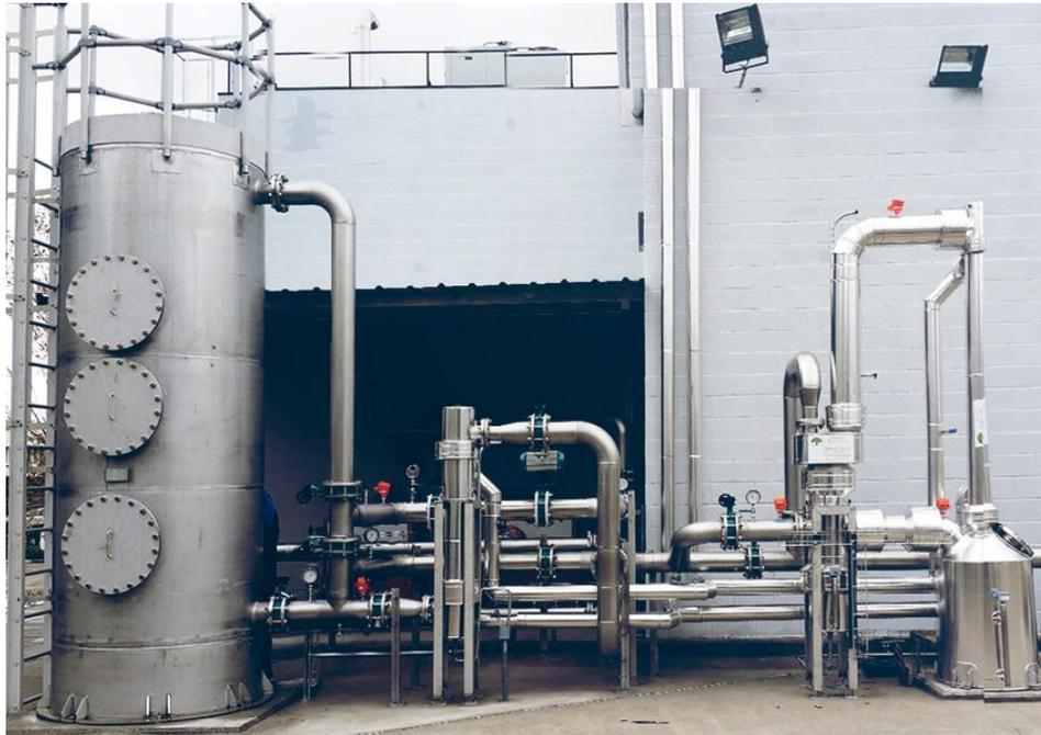
Figura 9.1: Sección de postratamiento de biogás de una planta en Dinamarca.
