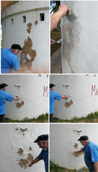
Fig. 41 Proceso de acondicionamiento del muro.
