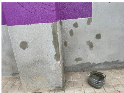
Fig. 42 Cemento muy diluido para poder cubrir las imperfecciones tanto del muro como errores al encajar.
