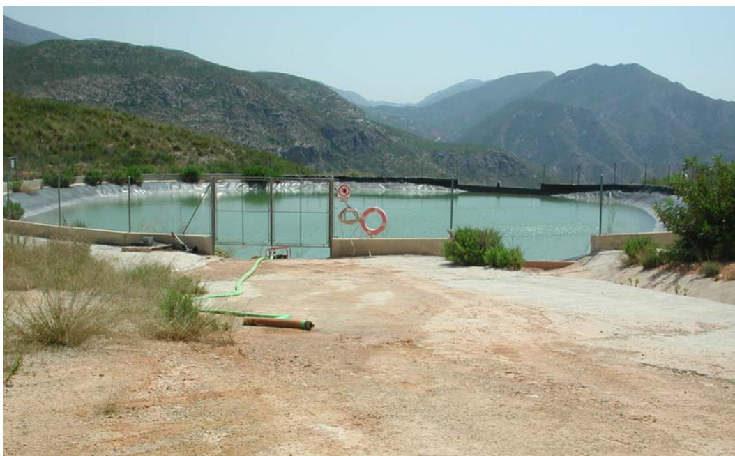
Figura 4.15: Balsa de tierra impermeabilizada con geomembrana para la acumulación de aguas pluviales recogidas dentro de la parcela de un vertedero de residuos no peligrosos en la Comunidad Valenciana.
