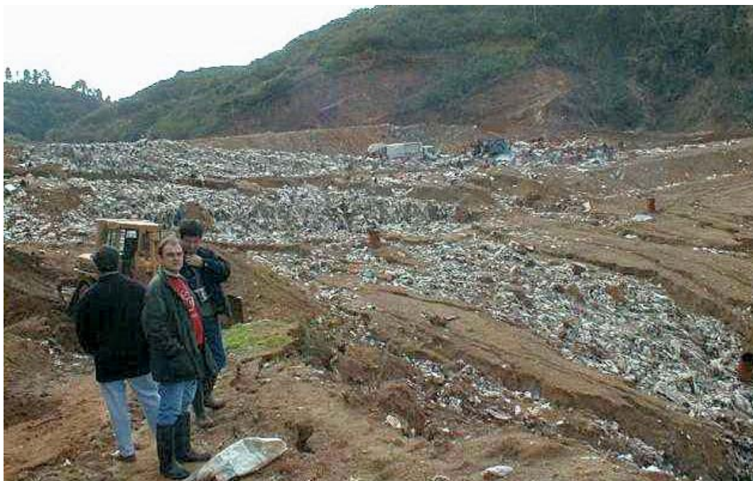
Figura 2.32: Erosión intensa del vertedero debido al agua de escorrentía de la montaña. Fuente: por cortesía del profesor Dr. Antonio Gallardo.
