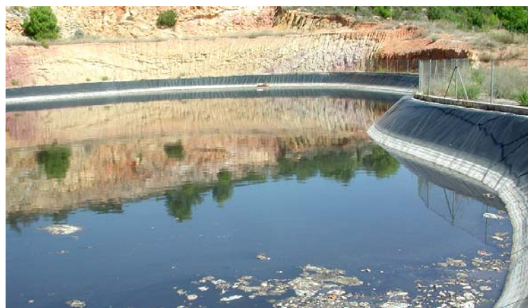
Figura 5.6: Balsa de lixiviados de una planta de compostaje.
