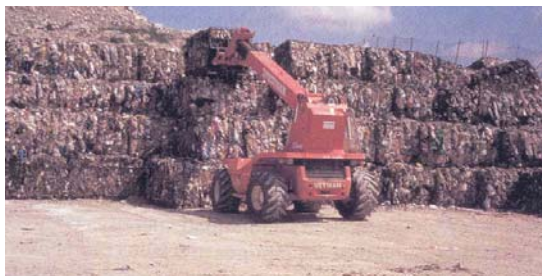
Figura 2.15: Carga de un vertedero de balas o fardos. Fuente: Hontoria et al. 2001
