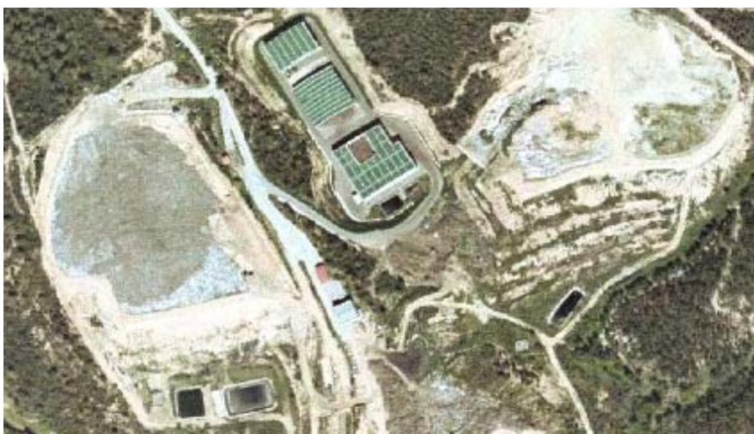
Figura 4.9: Ortofotografía aérea de una planta de compostaje, un vertedero antiguo y un vertedero en uso con sus correspondientes balsas de lixiviados. Fuente: SIGPAC. Ministerio de Agricultura, Pesca y Alimentación
