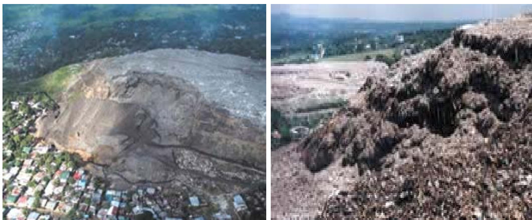
Figura 2.30: Vista aérea y frontal del desprendimiento del vertedero de Payatas en Filipinas. Fuente: (Kölsch et al. 2004)
