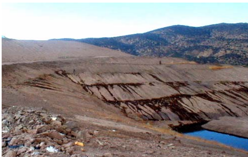
Figura 2.31: Vista general de la fuga de lixiviados en el Vertedero Loma Los Colorados. Fuente: por cortesía del profesor Marcel Szantó.
