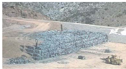
Figura 2.16: Vista general de un vertedero de balas, frente de trabajo con cobertura y chimeneas para la liberación de biogás. Fuente: Imabe Ibérica S.A.
