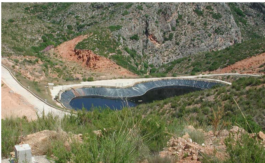
Figura 5.3: Balsa de lixiviados del vertedero de rechazos.
