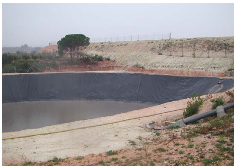
Figura 5.9: Balsa de lixiviados de un vertedero de residuos no peligrosos.
