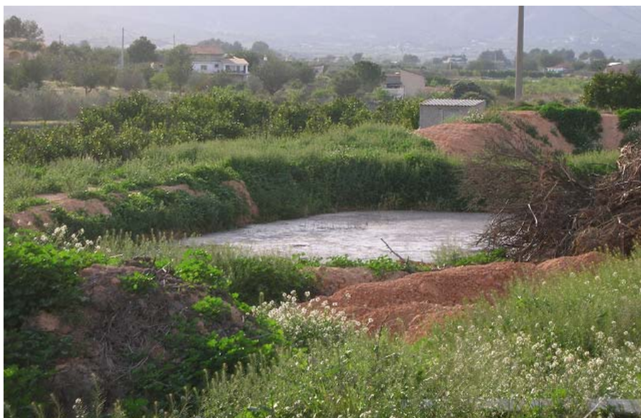
Figura 4.18: balsa de lixiviados de una explotación agropecuaria sin ningún tipo de diseño ni impermeabilización. Además del riesgo de rotura del dique, el terreno semipermeable, permite las filtraciones de líquidos contaminantes.
