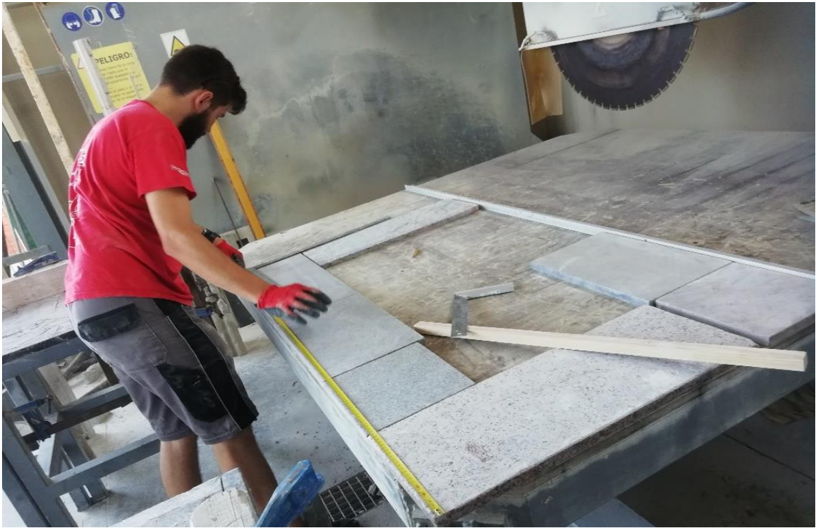
Anexo. Fig. 17. Francisco José Pía. Planteamiento sobre superficie nivelada los módulos a encolar. 2022.
