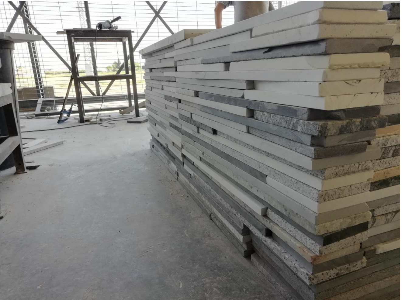
Anexo. Fig. 19. Adrián Taylor. Fotografía lateral del montaje del Mirador. 2022.
