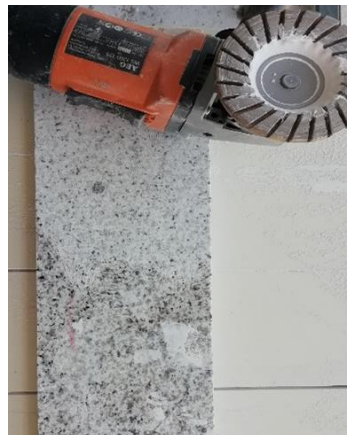
Fig.30. Adrián Taylor. Marcado y corte de las losas de piedra. 2022.
