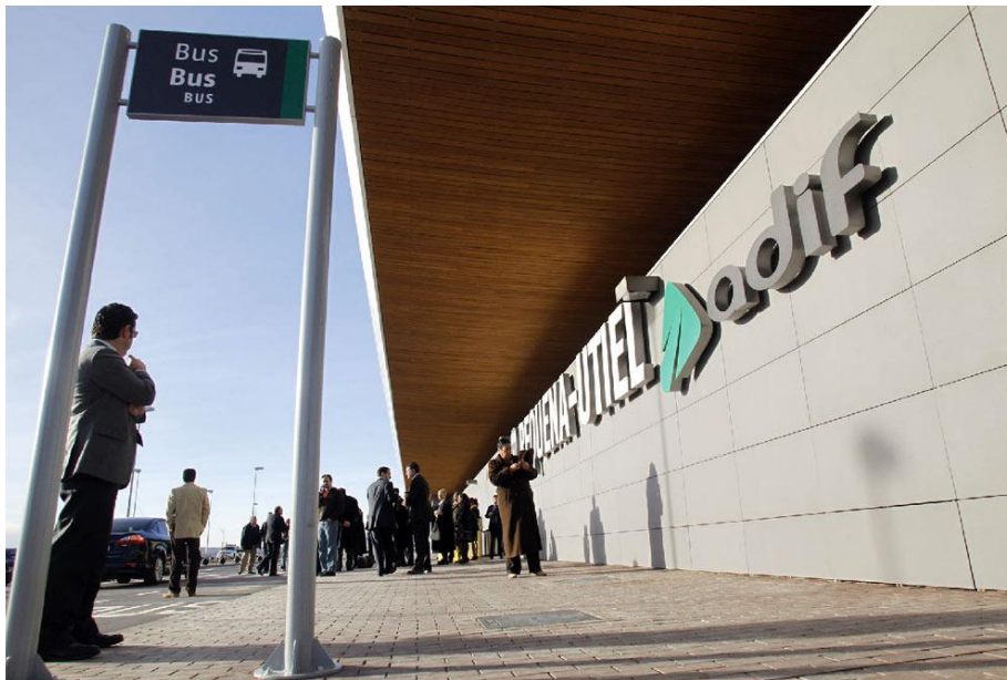
Imagen 29: Estación de tren de Alta Velocidad de Requena-Utiel.
