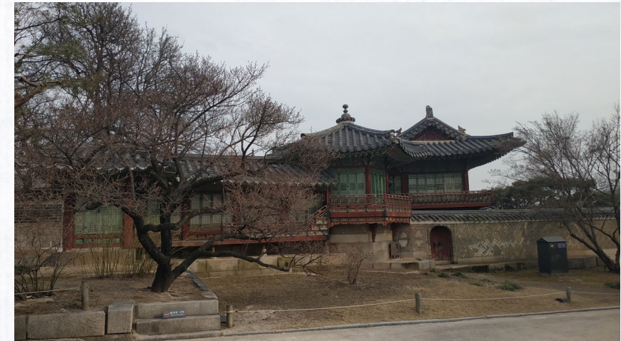
Fotografia pròpia al palau Changdeokgung
