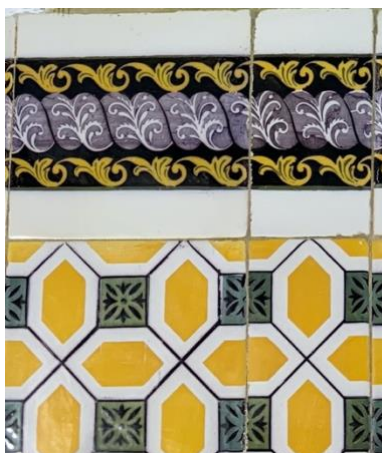
Fig. 8. Detalle del zócalo.
