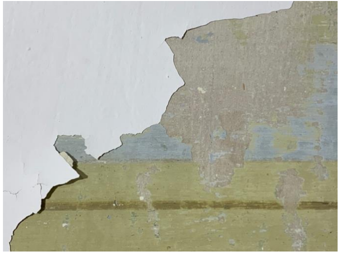
Fig. 61. Desprendimiento del encalado en la bovedilla 1.
