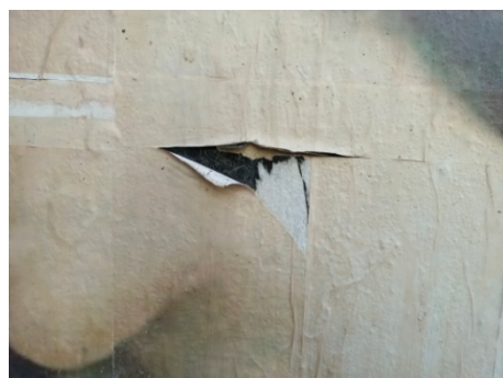
Figura 22. Detalle levantamiento y arranque del papel, de la película pictórica y de la pared. Foto. Silvia Catalá.
