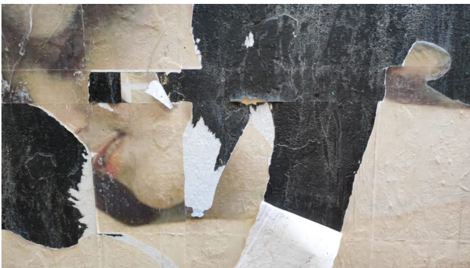
Figura 27. Detalle levantamiento, arranque, faltante y escorrientía (20-04-22). Foto. Silvia Catalá.
