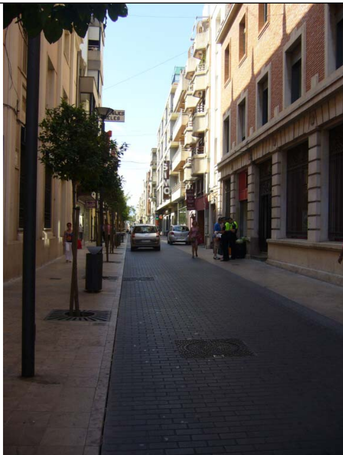
Calle Vallier, calle peatonal con coexistencia de tráfico rodado, pavimento de adoquín de hormigón, pertenece a la zona del Raval, presenta un considerable flujo de tráfico.
