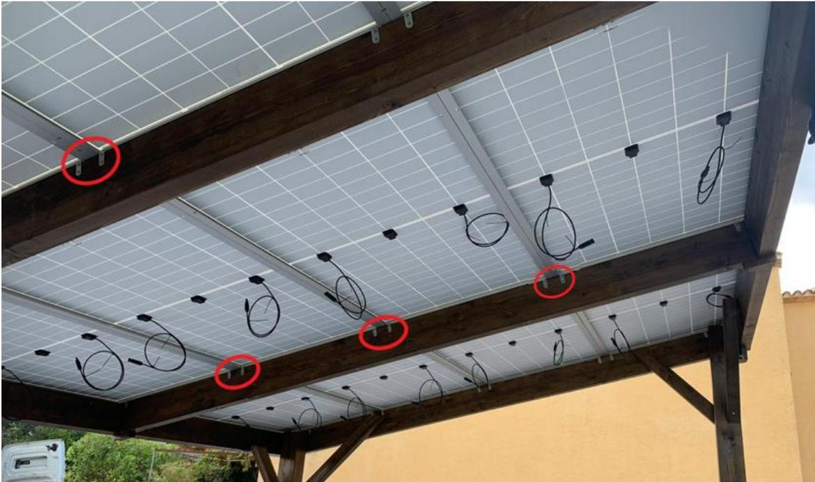
FIGURA 23. Imagen del anclaje de los paneles solares a la estructura de madera.
