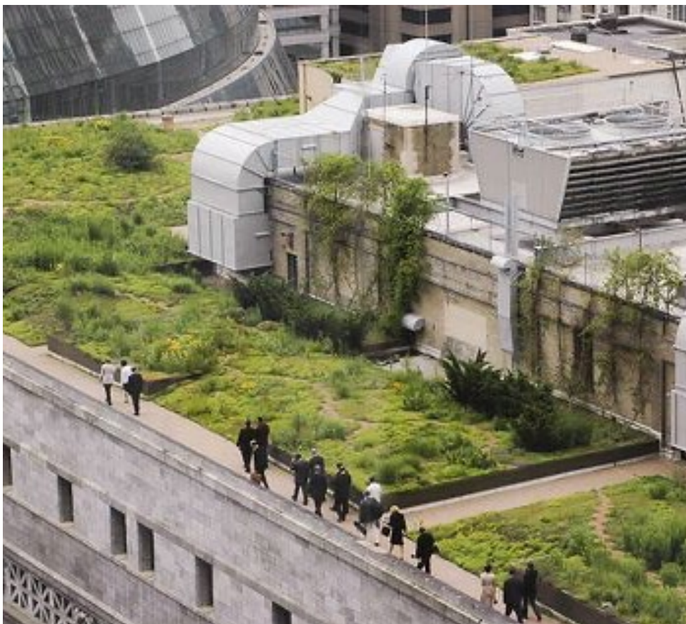
(Fig.12) Cubierta Ayuntamiento de Chicago.
