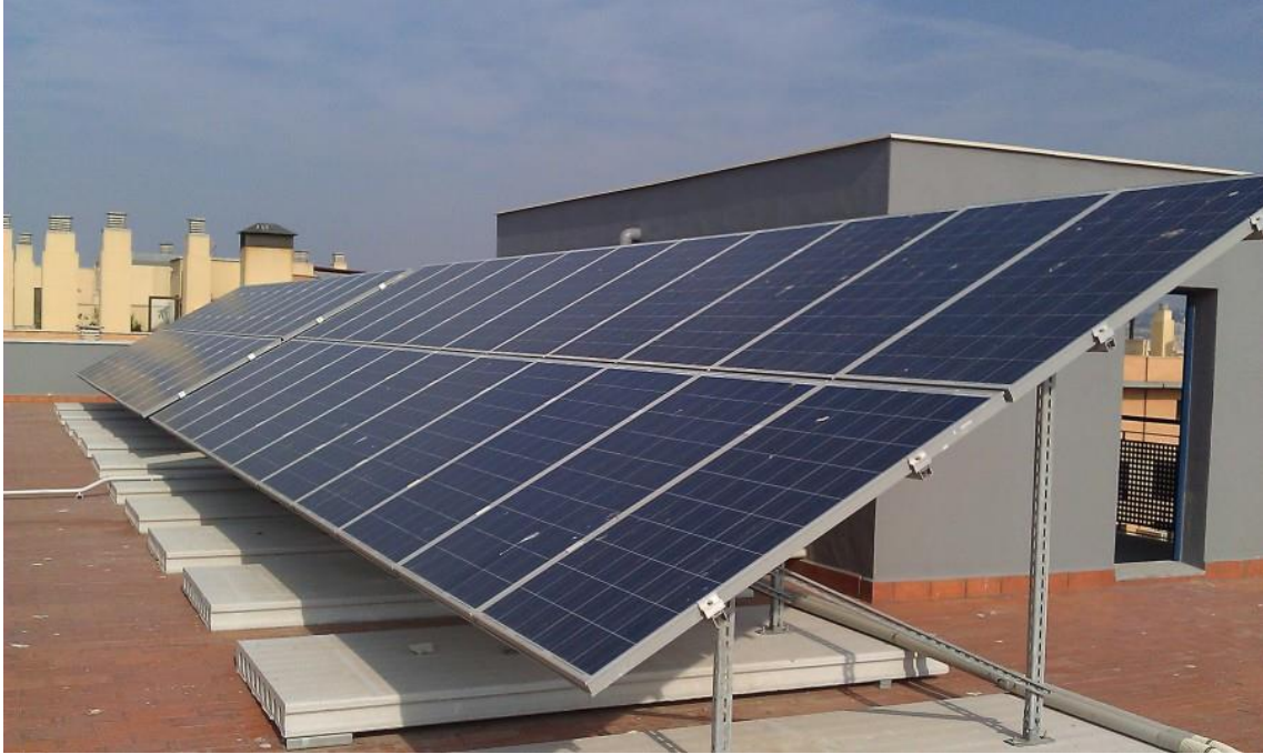
Imagen 3: Estructura inclinada sobre la cubierta plana de un edificio.
