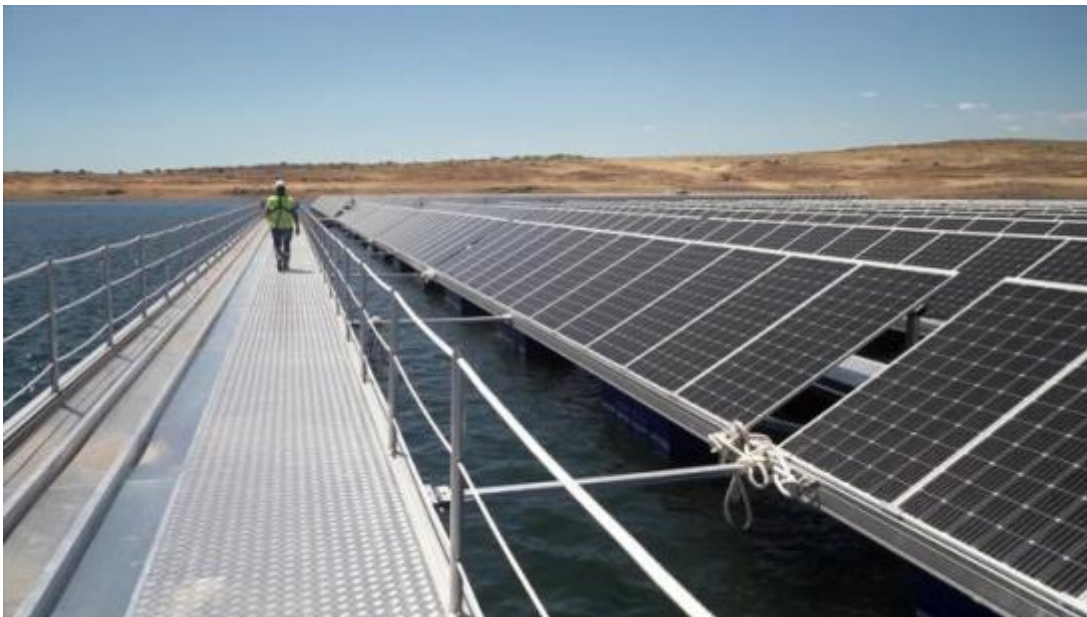
Imagen 5: Estructura flotante en Sierra Brava (Extremadura) instalada por "Acciona".
